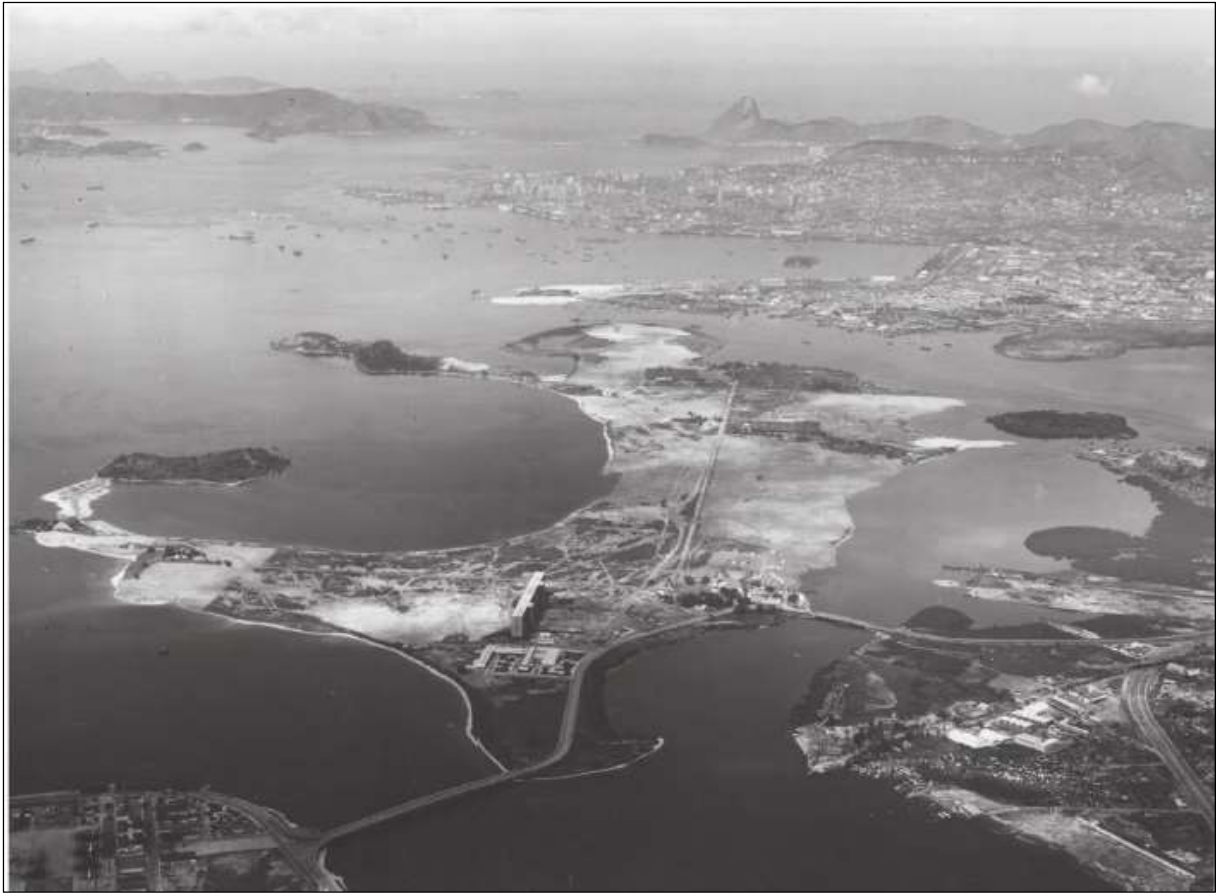
Figura 3: Aterro hidráulico para a construção do campus universitário. Fonte: Acervo do Núcleo de Pesquisa e Documentação, FAU/UFRJ, Brasil, 1950.
