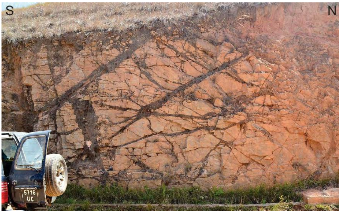
Figura 4.14: Afloramento do ponto LOC-87, caracterizado por quartzito maciço, com colocação rosa-alaranjado e com veios cortando esta unidade.
