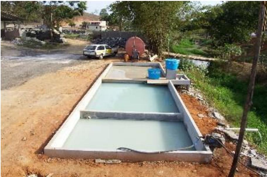
Foto 10: Tanque para recepção e decantação de efluentes líquidos das serrarias. Os tanques instalados, além de reterem os resíduos gerados pelo corte das pedras, impedindo o despejo nos córregos e rios locais, permite a recirculação da água utilizada no processo de corte, ocasionando economia de água (extraído do Relatório RETECMIN – fevereiro/2003).
