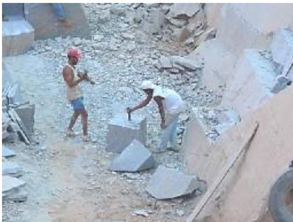
Foto 22: Desdobramento dos blocos em lajes. Enquanto um operário segura a talhadeira para a abertura das lajes, o outro aplica a força necessária usando de marreta de 10 kg.
