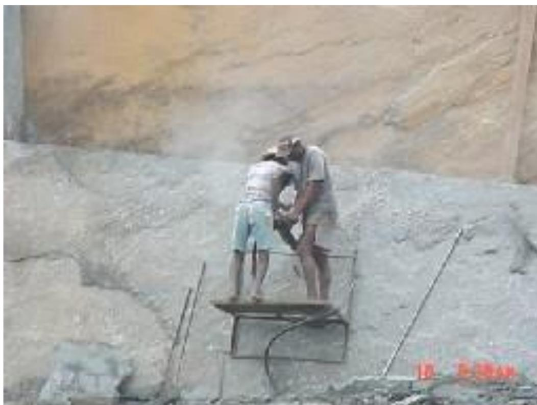
Foto 20: Operários realizando perfuração na rocha, com uso de martetele pneumático. Nota-se na foto a ausência de equipamentos de segurança, colocando em risco a integridade física dos trabalhadores.
