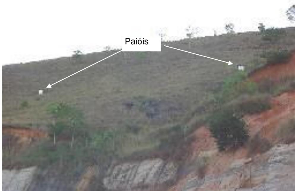
Foto 18: Paióis para armazenamento de explosivos. Além da localização inadequada (notar talude e pedreira abaixo), os mesmos estão abandonados.
