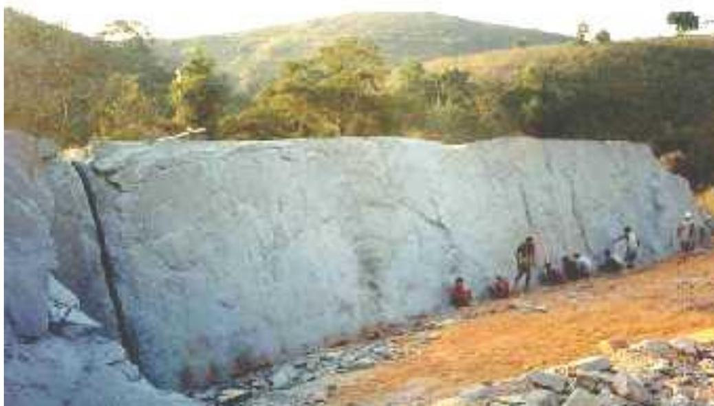
Foto 19: Carregamento de furos para realização de corte horizontal com uso de explosivos. À esquerda visualiza-se corte com jet flame para isolamento do quadrante.
