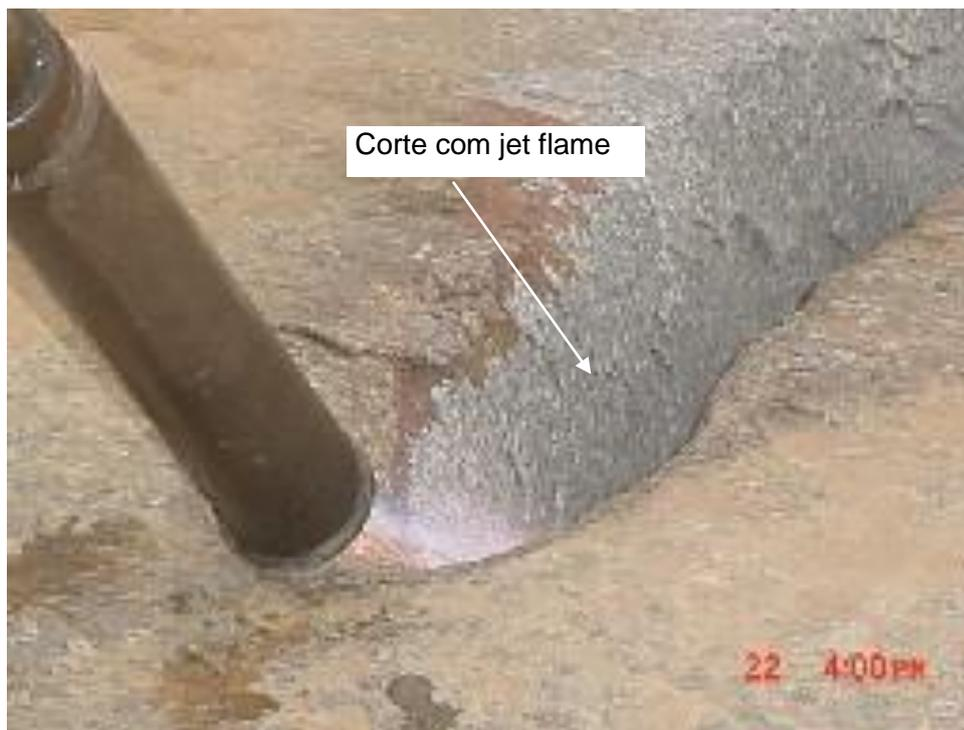
Foto 5: Jet flame em ação – notar a chama em tom claro saindo do bico queimador devido à pressão do ar comprimido, que, além de forçar a quebra da rocha, serve para limpeza do canal de corte. Observar, também, a largura do corte – aproximadamente 15 cm.
