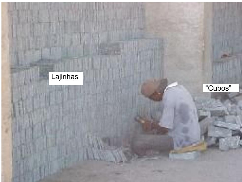
Foto 28: Operação de desdobramento das lajinhas. O operário, através do uso de macetas e talhadeiras, aplica esforço na direção da foliação da rocha, deslocando-a.
