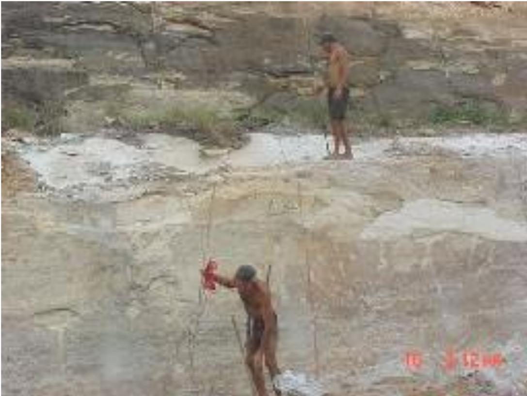
Foto 3: Uso de explosivos em pedreira de pedra madeira. Observar o operário manuseando cordel detonante (abaixo, na foto), sem qualquer orientação técnica. Ainda, como risco da operação, o operário (parte superior da foto), realiza a colocação e compactação do explosivo utilizando-se de haste metálica, o que pode causar detonação pelo atrito da mesma com a rocha.
