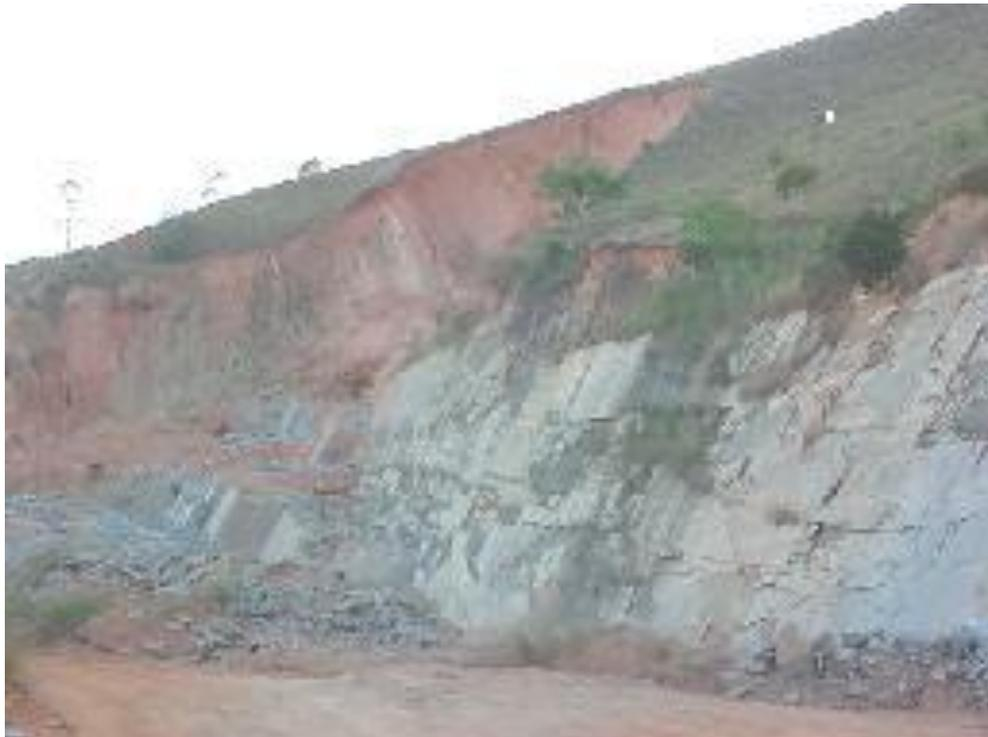
Foto 15: Devido à falta de planejamento, muitas áreas apresentam instabilidade de solo (talude), onde, no período de chuvas, ocorre deslizamento de solo, cobrindo a frente de lavra.
