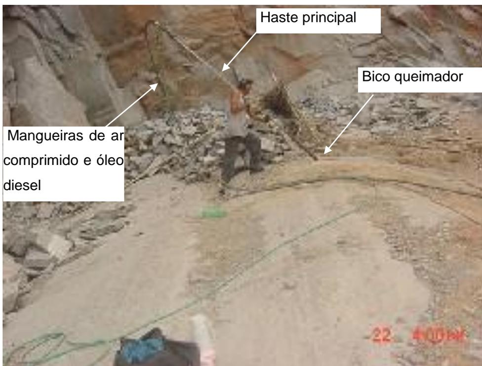
Foto 4: Operação do jet flame. O equipamento consiste em uma haste principal, que conduz o ar comprimido e o óleo diesel (entrada na parte superior) para o bico queimador (foto 5). O operador conduz a haste no plano desejado para corte.
