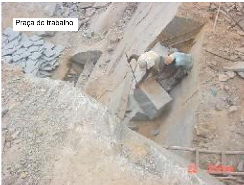
Foto 21: Situação de risco – Operários extraem blocos maiores para desdobramento em lajes, que seguirão para a serraria. Na operação os operários lançam o bloco para a praça de trabalho, a uma altura de, aproximadamente, 12 m, sem qualquer proteção.
