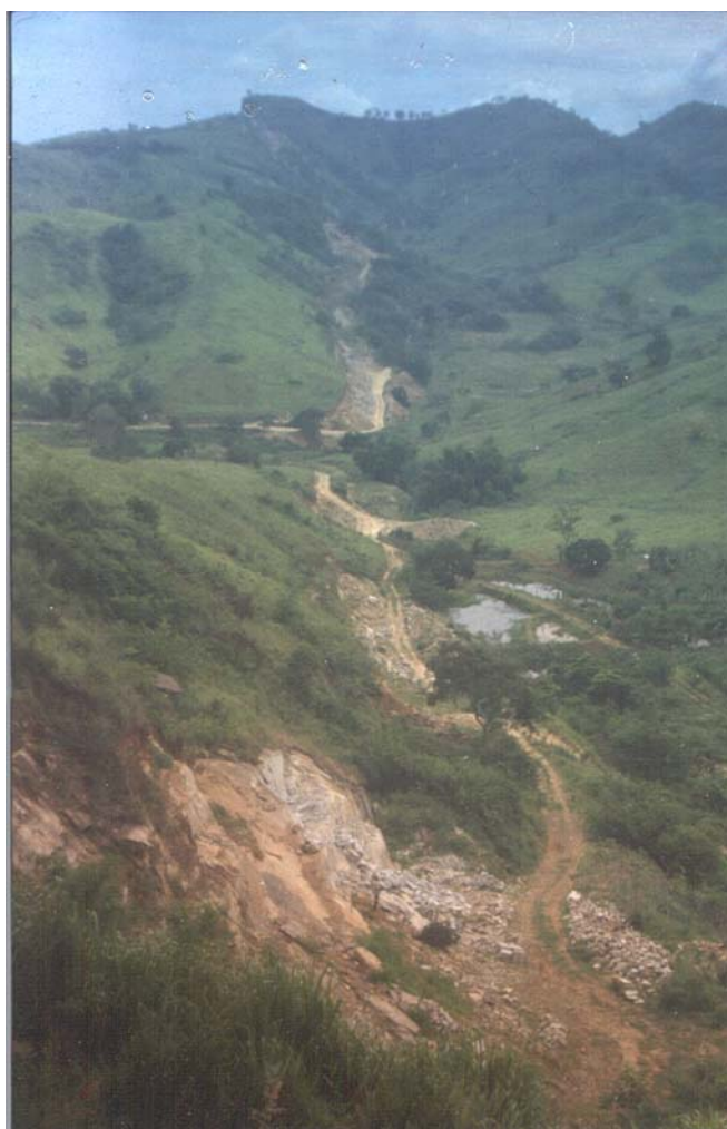
Figura 16 : alinhamento das lavras de rocha ornamental ao longo da zona de cisalhamento
