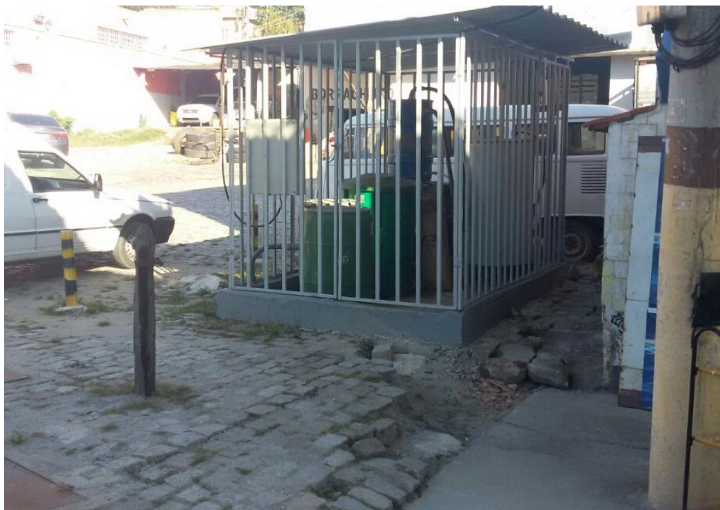
Figura 13. Sistema MPE em funcionamento.
