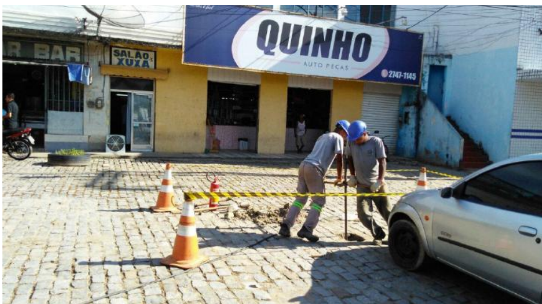
Figura 7. Equipe executando sondagem a trado manual.
