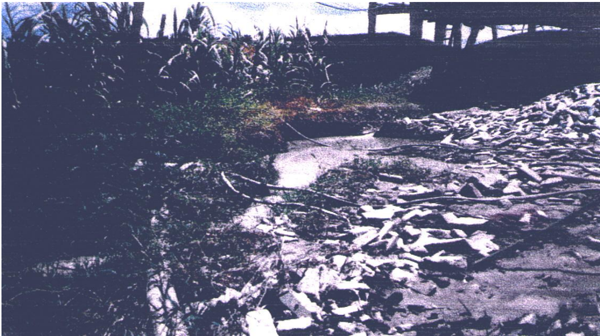
Foto 08: Tanque de decantação, ineficaz, apresentando transbordamento de material.
