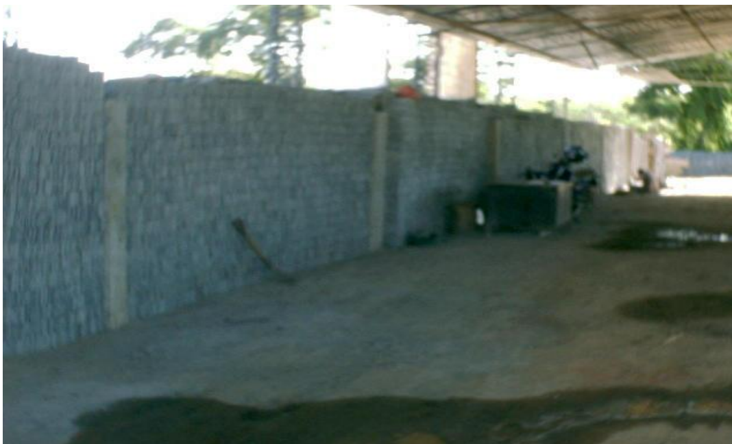
Foto 06: Vista do galpão de armazenagem das lajotas já beneficiadas
