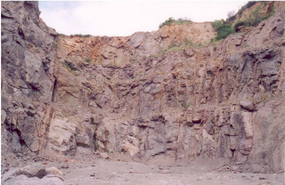
Figura 24: Visão geral da frente de lavra do Gnaisse facoidal 2: intenso fraturamento.
