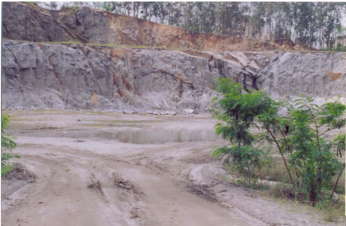
Figura 19: Visão geral da compartimentação / fraturamento do maciço rochoso do Gnaissé facoidal 1.
