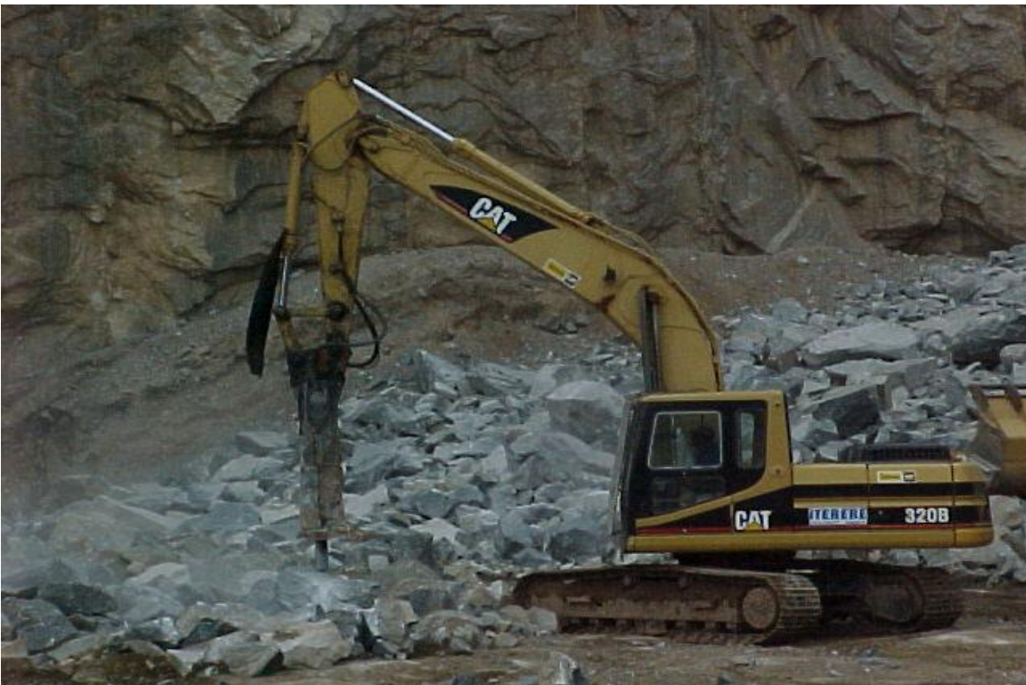
Figura 14: Detalhe do desmonte dos blocos na pedreira do Charnoquito.
