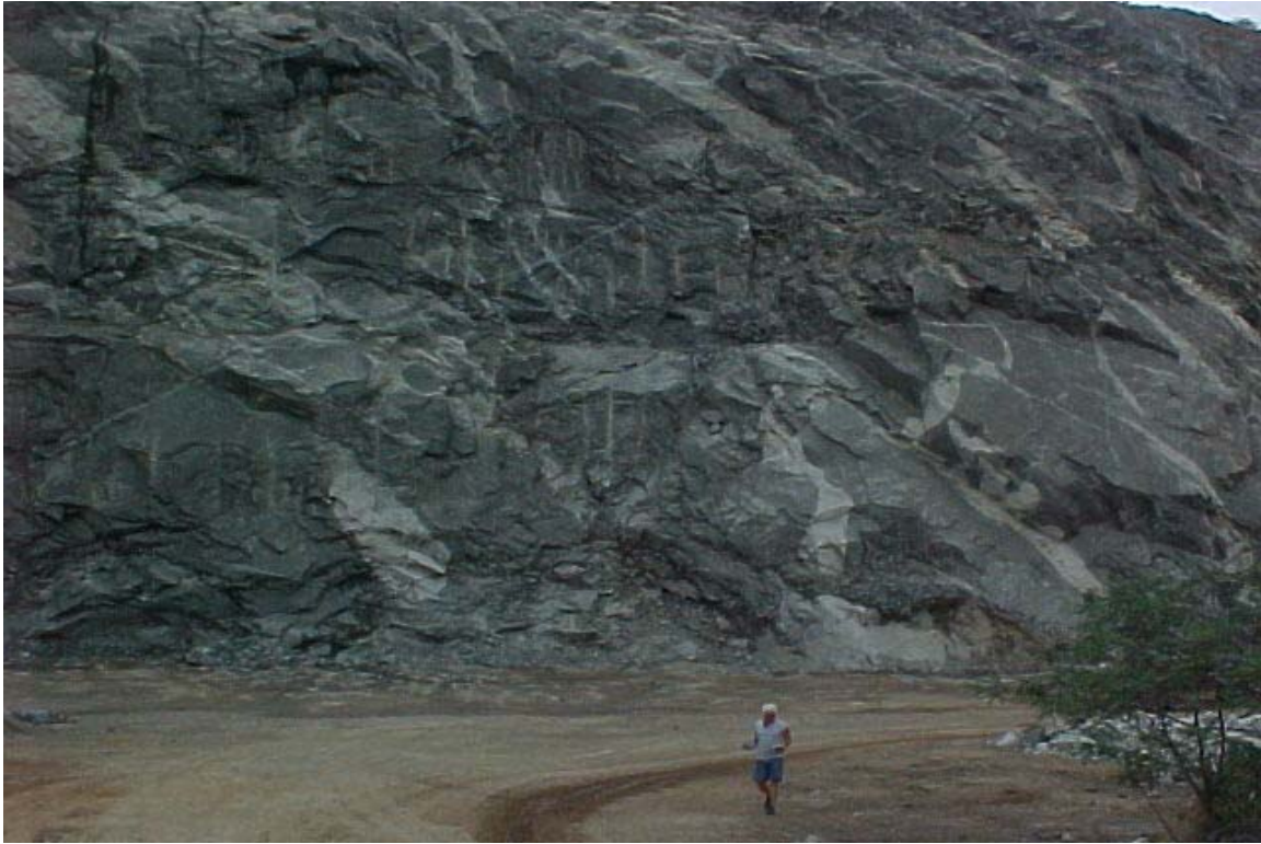
Figura 13: Detalhe do fraturamento irregular na frente de lavra do Charnoquito.
