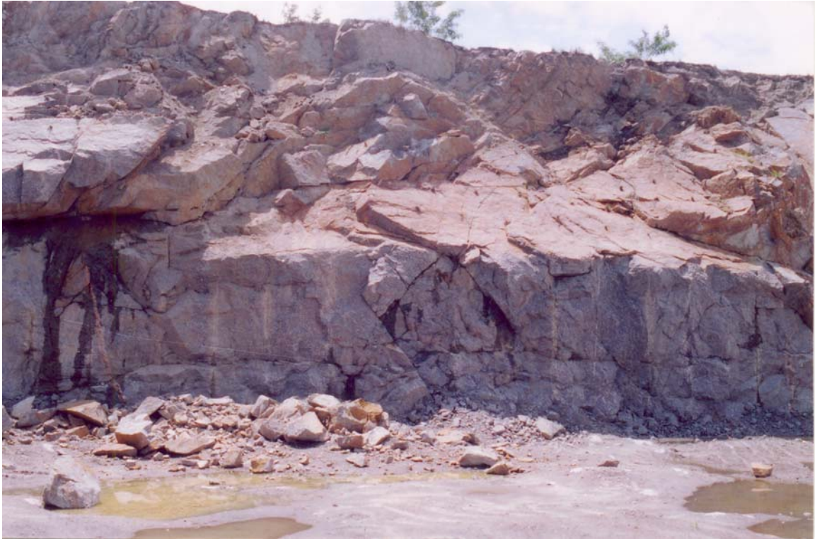
Figura 20: Detalhe do fraturamento do maciço rochoso do Gnaiss facoidal 1.
