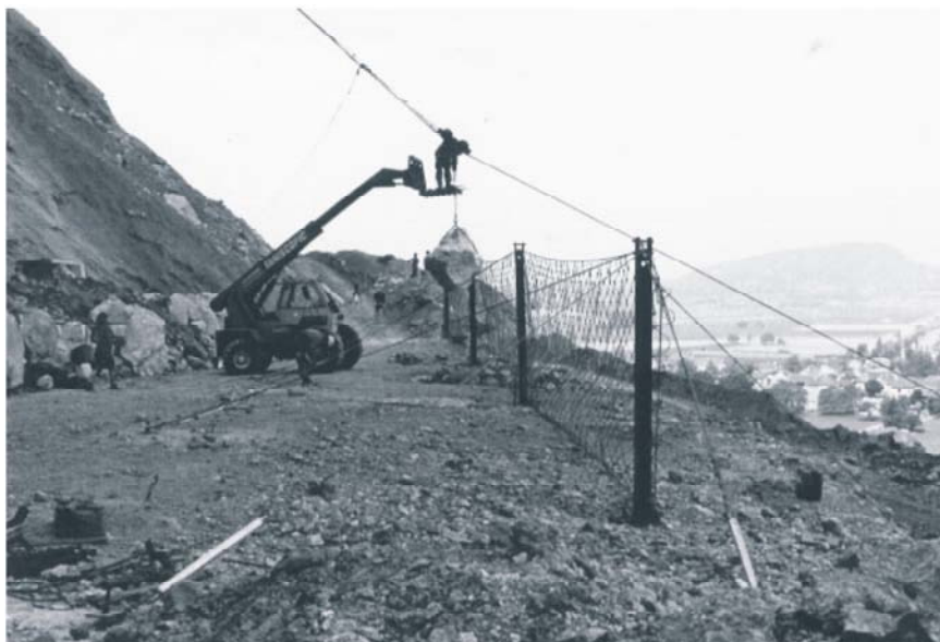
Figura 1.2 – Exemplo de barreira de contenção com tela metálica – Itália (Peila et al., 1998).
