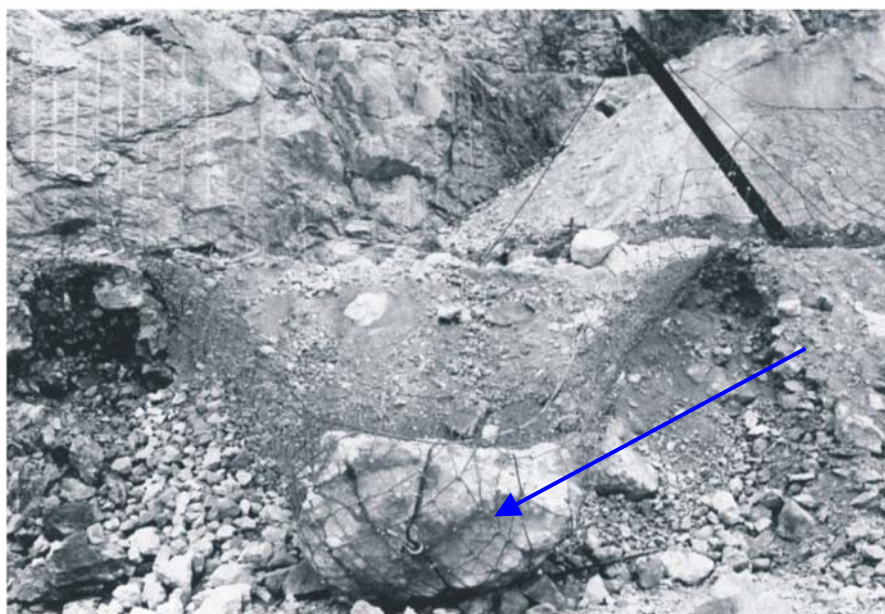
Figura 1.3 – Barreira em tela impedindo a passagem de bloco – Itália (Peila et al., 1998).
