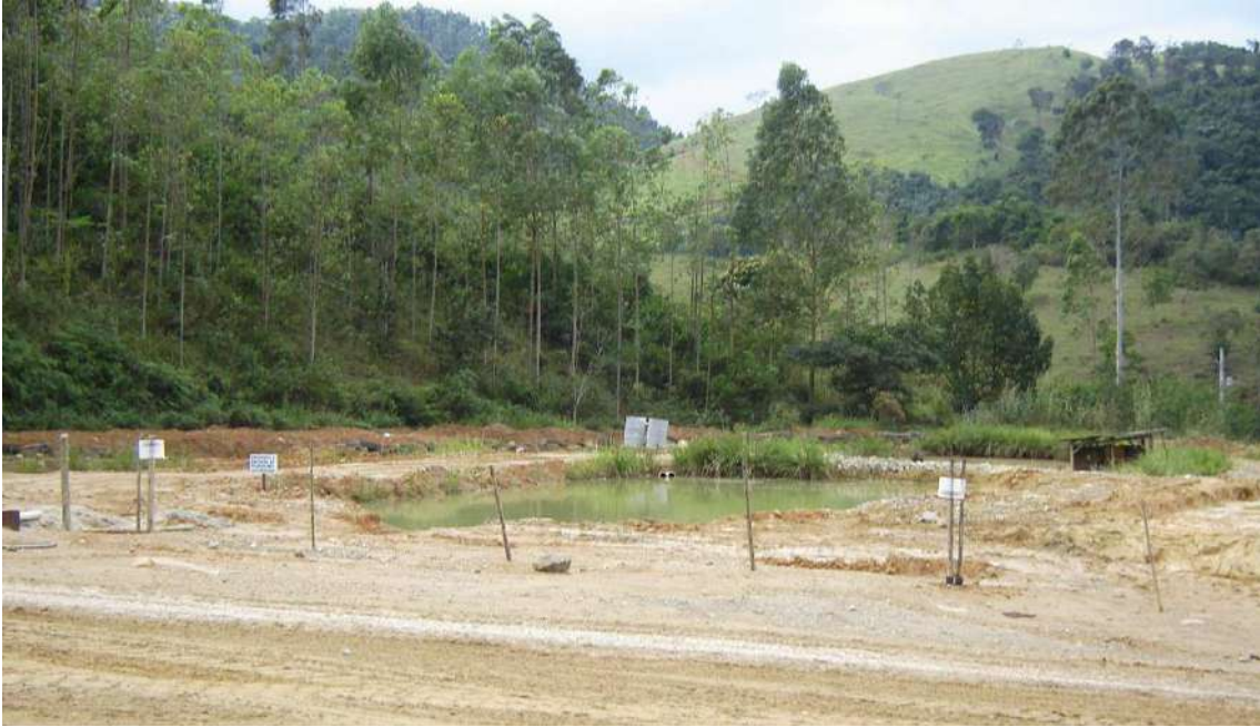
Figura 8: bacia de decantação de água proveniente da frente de lavra.
