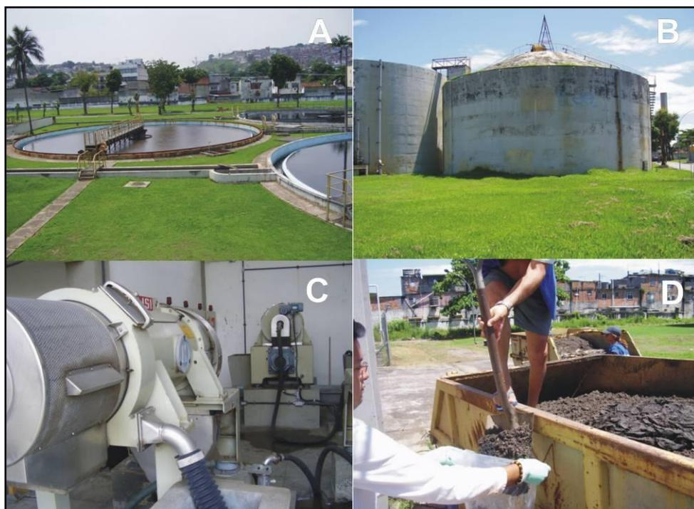
Figura 1. Etapas do processamento e coleta do lodo na ETIG: (a) decantadores; (b) digestores; (c) centrífuga de desaguamento e (d) coleta no caminhão caçamba. Fonte: Alamino (2010).
