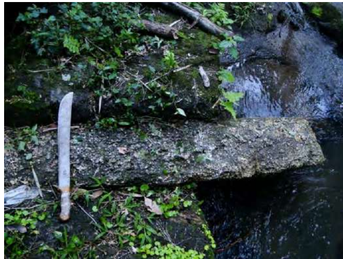
Figura 29: Dique do Granito Caju
