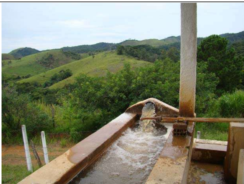
Figura 3 - Locais de armazenamento de água bruta na Estação de Tratamento de Água em Vila Mariana, em Mendes, água captada do rio Santana.
