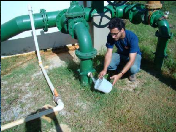
Figura 39 – Água captada em poço na ETA de Farol de São Tomé
