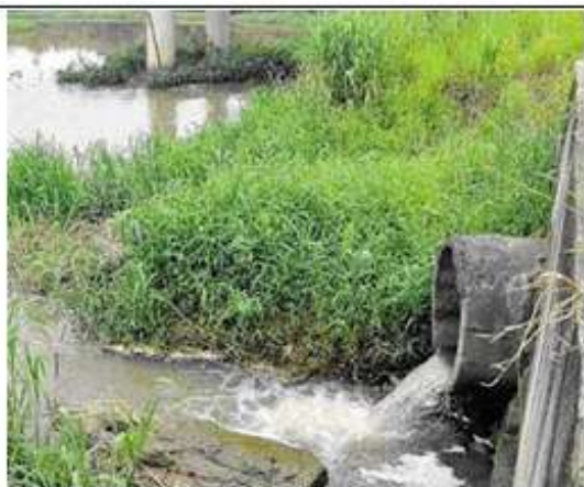
Figura 33 - Lançamento de esgoto sem tratamento no rio Paraíba do Sul, no trecho de Taubaté; por dia, a bacia recebe até 75 toneladas de detritos.
