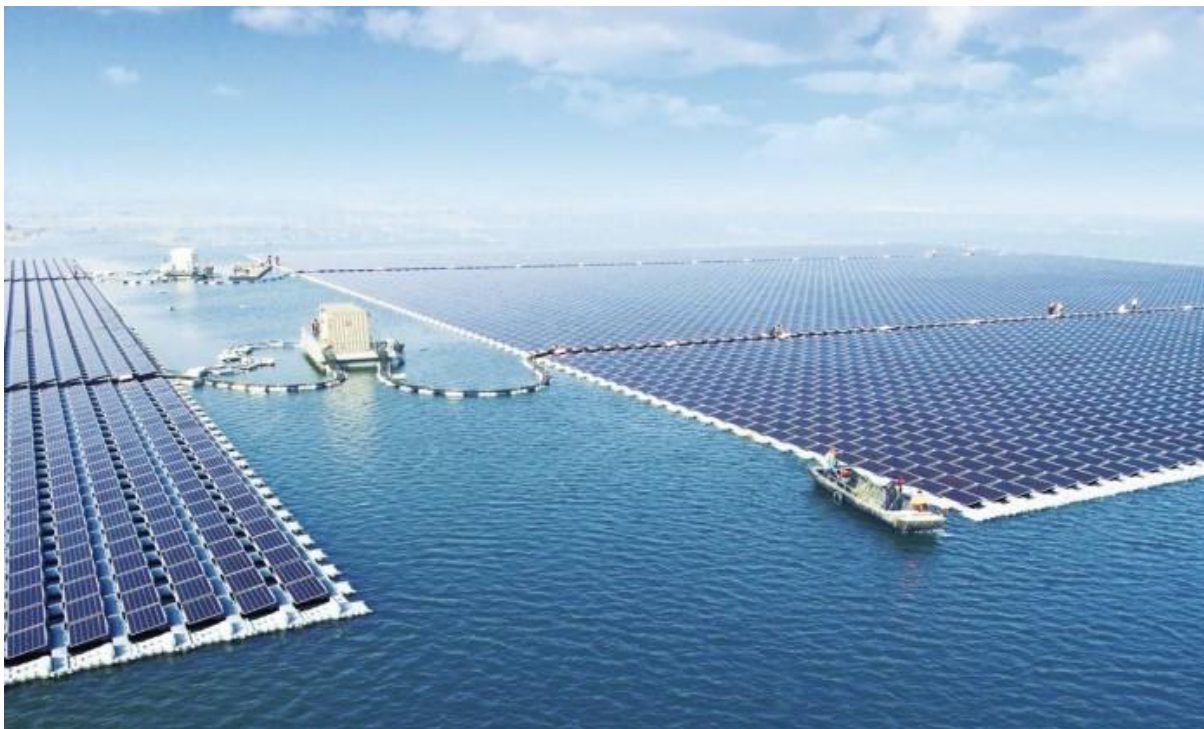
Figura 9 - Maior usina solar flutuante do mundo, localizada na China.
