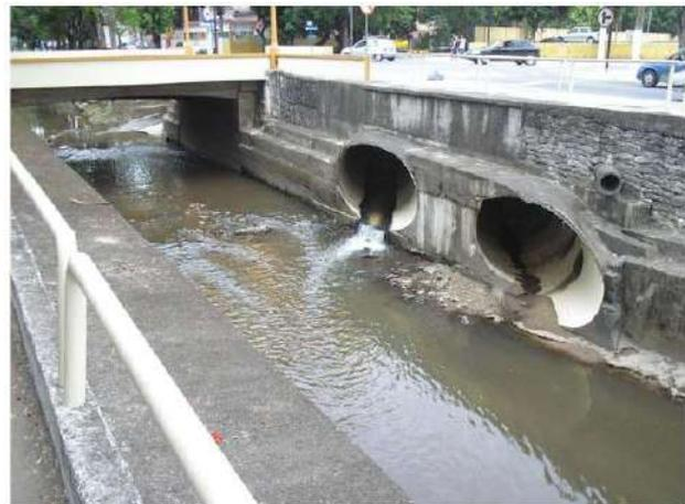
Figura 44 - Parte do sistema de esgoto sendo despejado no rio Brandão. fonte: Rodrigues (2008).
