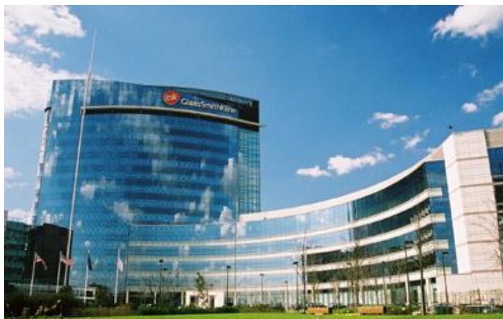
Figura 4: GSK House – Sede Reino Unido Fonte: www.gsk.com (acesso em 29/05/13)
