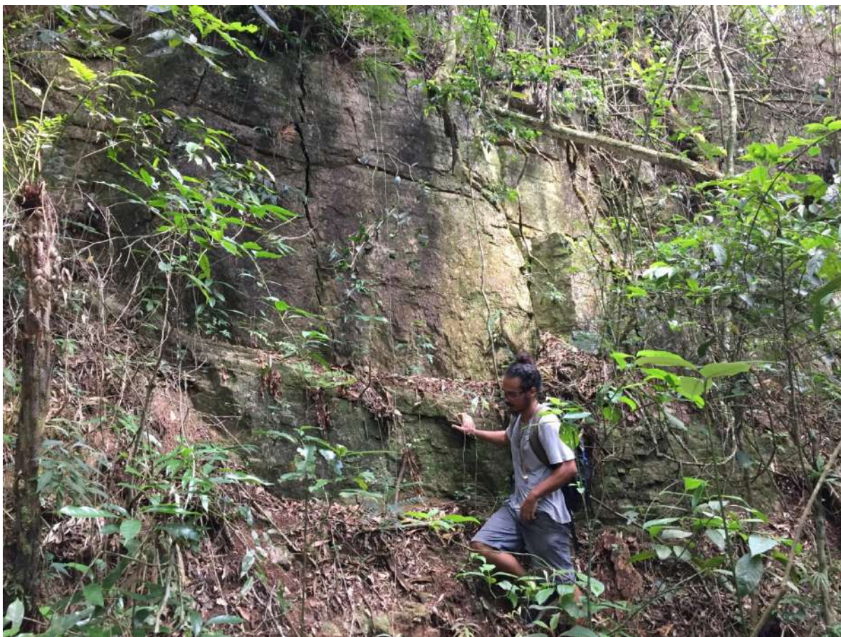
Figura 29- Parede de quartzito com conjunto de fraturas perpendiculares entre si.
