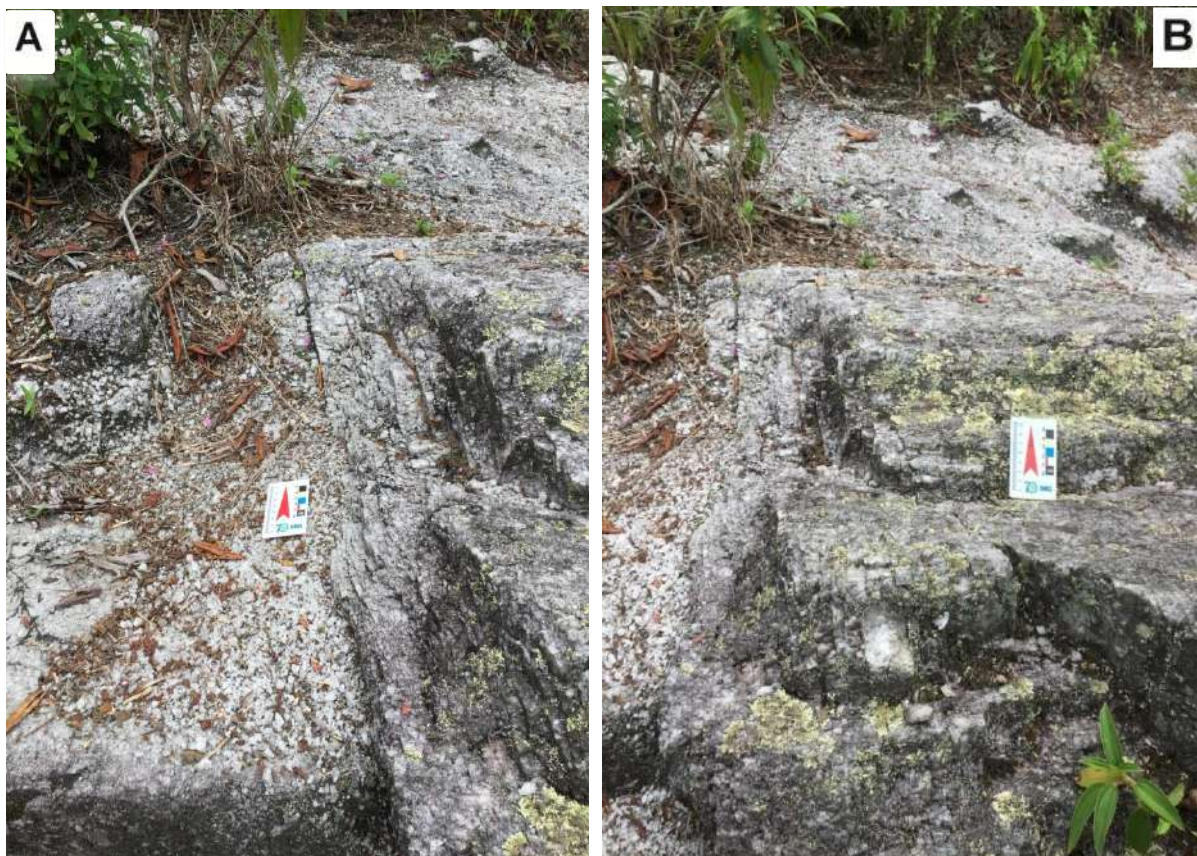
Figura 26 - Controle estrutural sobre o afloramento. Notar superfícies de fratura espaçadas e verticais e a foliação metamórfica, formando degraus no plano horizontal. (A) e (B) representam as perspectivas frontais e laterais de um mesmo ponto.
