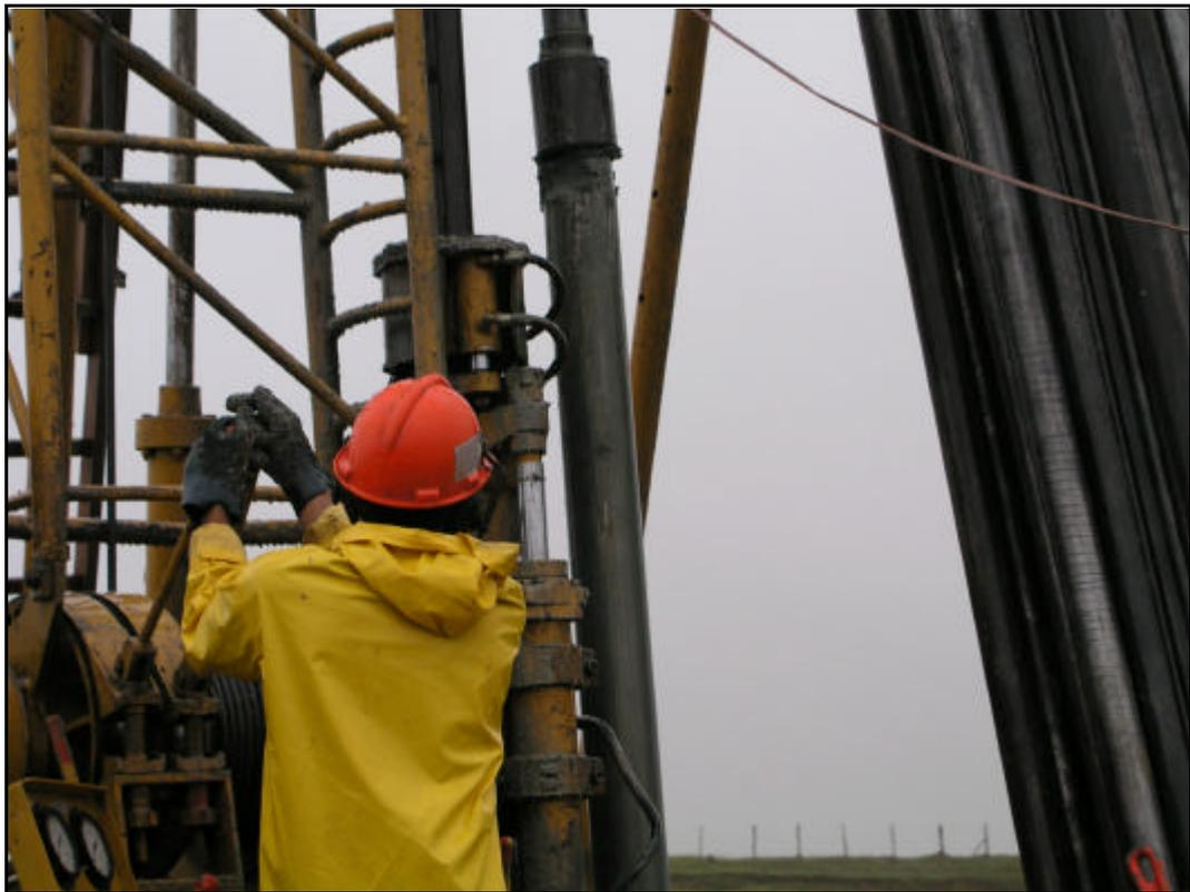
Figura 08: Manobra para retirada do barrilete de testemunhagem.
