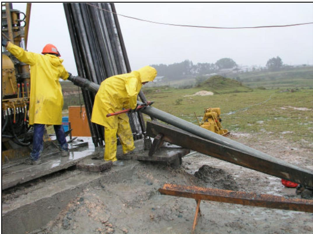
Figura 09: Retirada do barrilete do poço.
