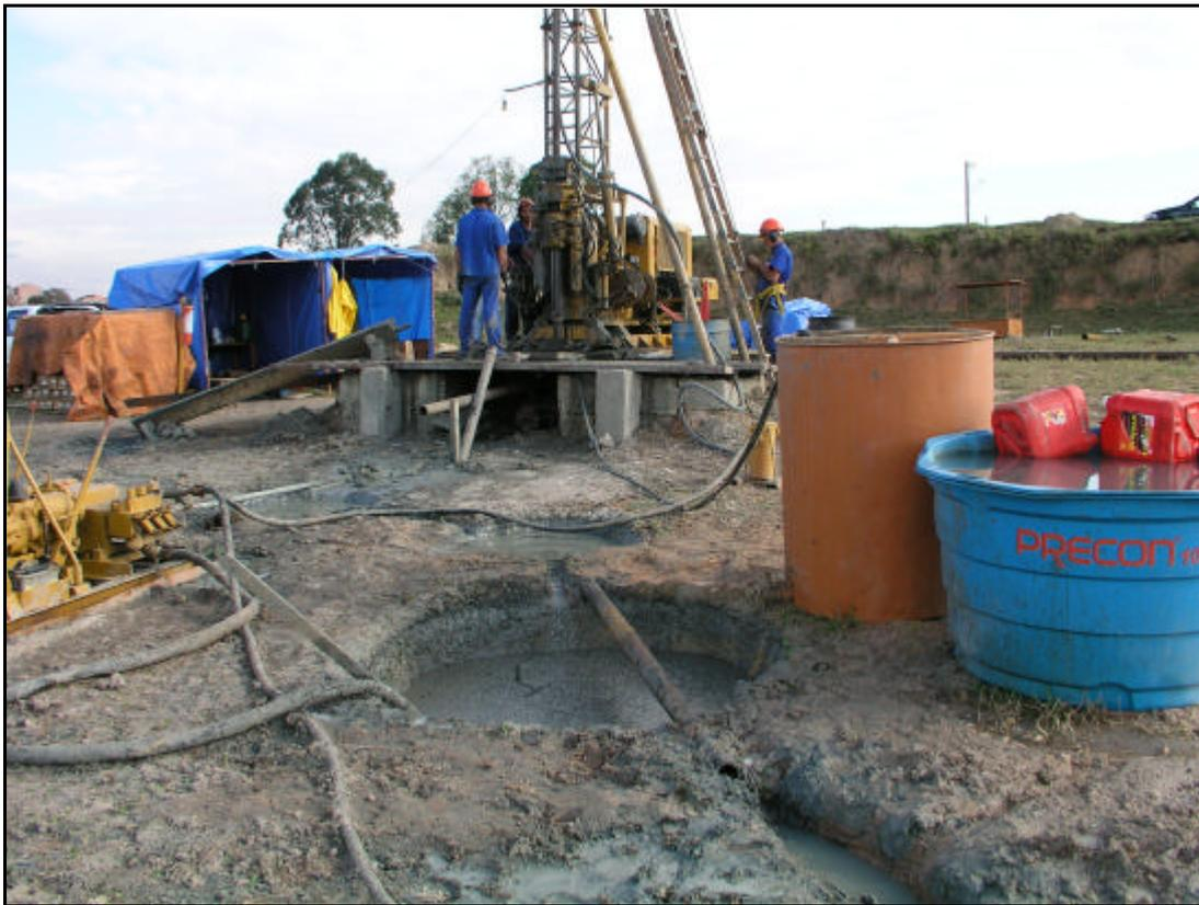
Figura 07: Base da sonda de perfuração com BOP.
