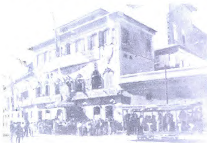
Figura 47: Prédio do Liceu de Artes e Ofícios, reformado, depois do incêndio de 1893
