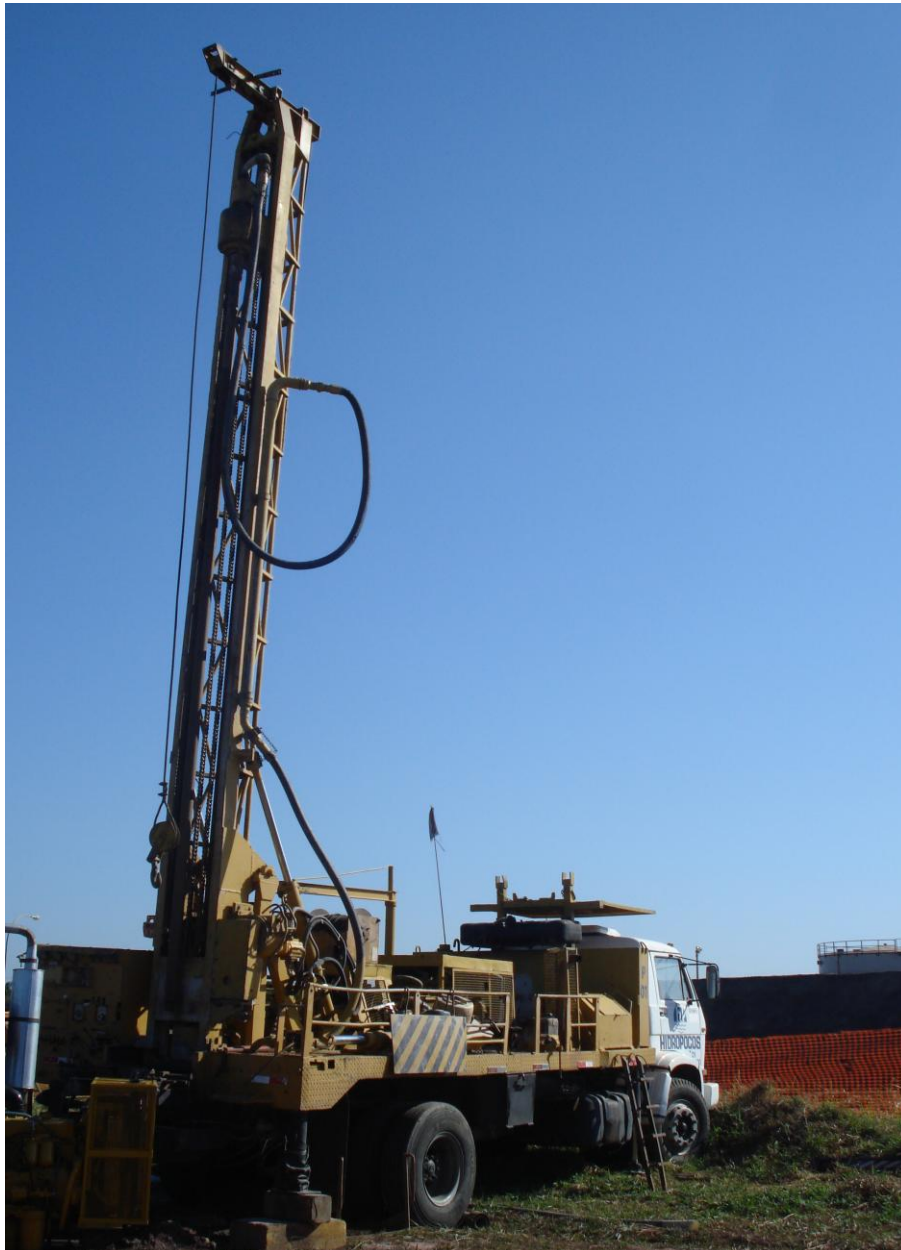
Figura 10: Máquina perfuratriz rotativa. Foto do autor.
