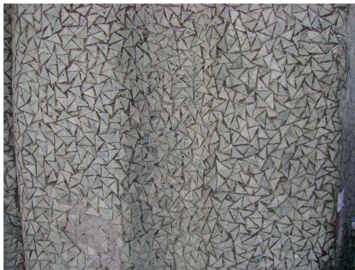
Figura 21 – Fotografia mostrando a parte externa do Cristo Redentor evidenciando o mosaico de pedra-sabão.
