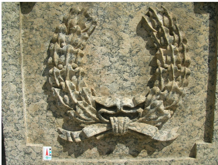
Figura 3 – Foto de rocha utilizada como revestimento da fachada do Museu de Ciências da Terra do Serviço Geológico do Brasil - a CPRM, trabalhada em gnaiss facoidal, mostrando beneficiamento ornamental na forma entalhes. Foto: Kátia Leite Mansur.
