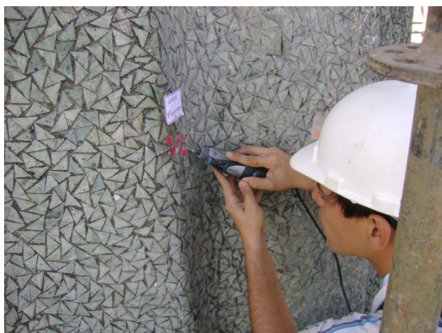
Figura 22 – Fotografia do momento da retirada das tesselas de pedra-sabão da parte externa da estátua.
