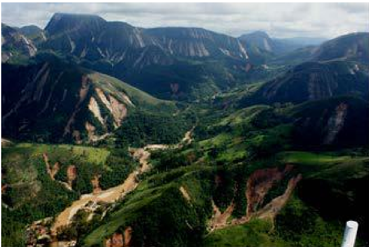
Figura 1: Visão panorâmica mostrando os vários escorregamentos que ocorreram nas montanhas de Nova Friburgo, Região Serrana do Estado do Rio de Janeiro, no dia 12 de janeiro de 2011. A maioria dos deslizamentos foi do tipo translacional raso. Fonte: Avelar et. al. (2011).
