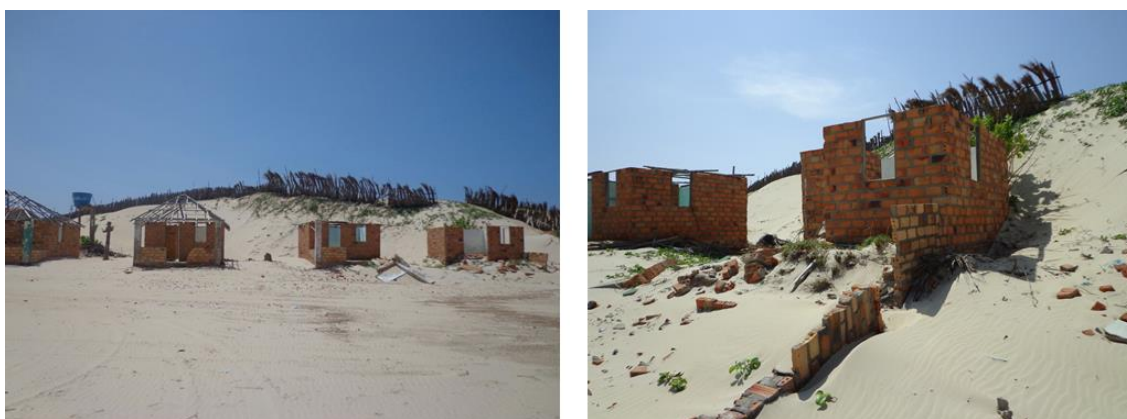
Figura 1. Efeito da erosão eólica na região dos Lençóis Maranhenses. (Foto do autor. Agosto de 2014)
