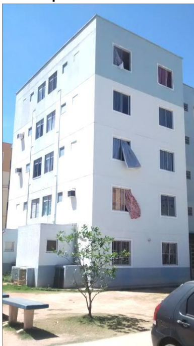
Figura 5 – O CH Parque Valdariosa: um dos 75 edifícios.
