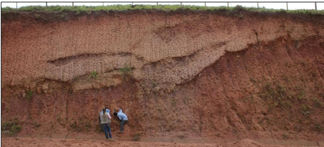
Figura 5.20: Parte central do afloramento da Formação Barreiras no ponto MC-CZ-01, destacando-se o deslocamento por falha das camadas sedimentares.
