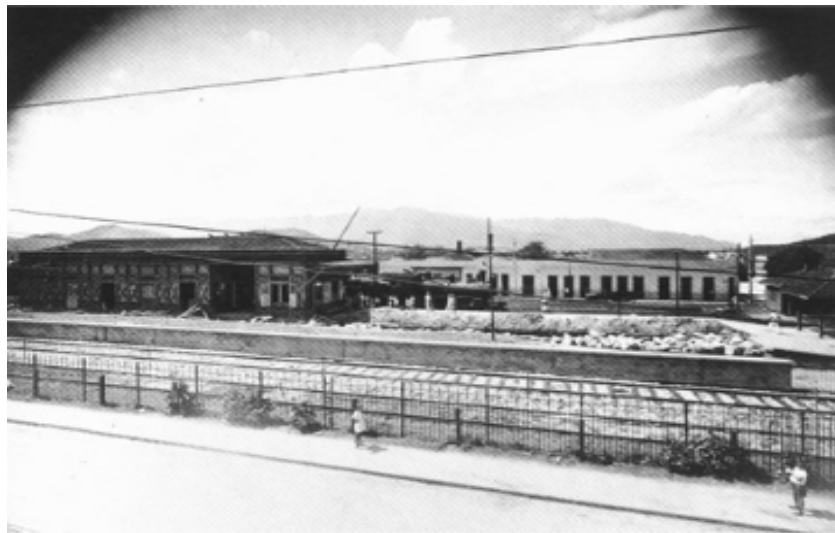
Figura 5: Obras da estação de Trem de Bangu
