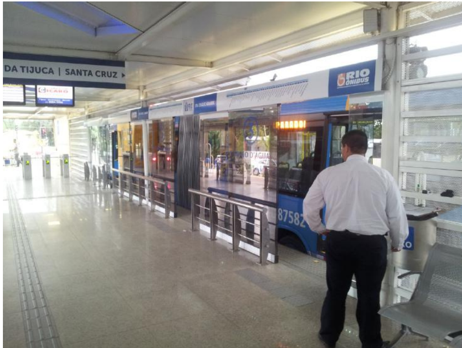
Figura 13: Exemplo de embarque e desembarque em nível da estação
