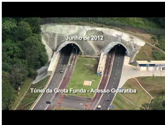
Túnel da Grotta Funda, obra realizada para a abertura de via para o BRT TransOeste. Fonte: http://www.cidadeolimpica.com
