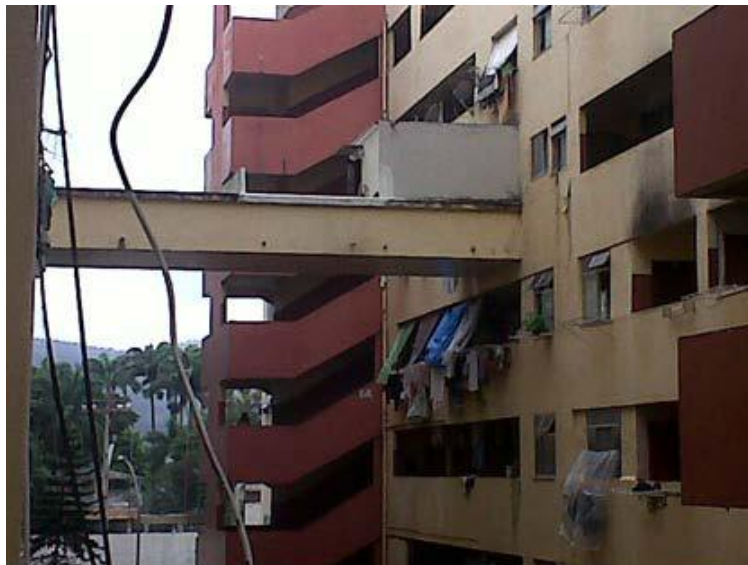
Figura 12 - Ponte (3º bloco)
