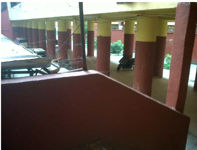
Figura 10 - Pilotis de sustentação 1º pavimento (3º bloco)
