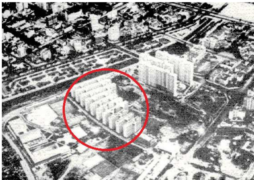
Figura 9 - Vista área da Cruzada São Sebastião.
