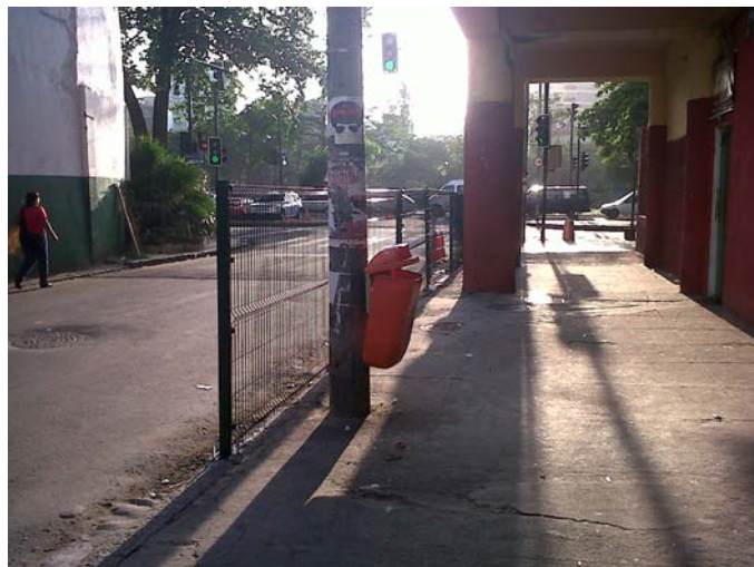
Figura 13 - Grades de contenção instaladas nas calçadas da Cruzada São Sebastião.
