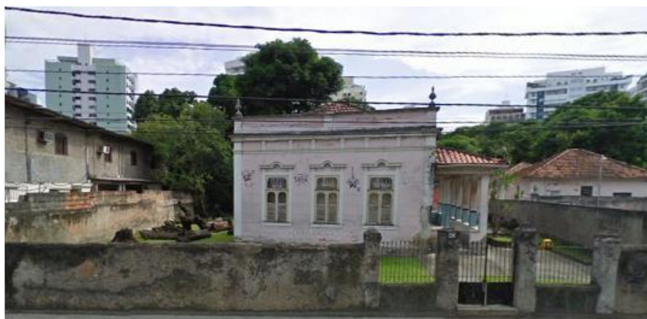
Figura 9: Uma antiga casa resistindo em tempos de verticalização na Rua Mário Vianna, Santa Rosa. Fonte: Google Street View e Arquivo do autor (2011).
