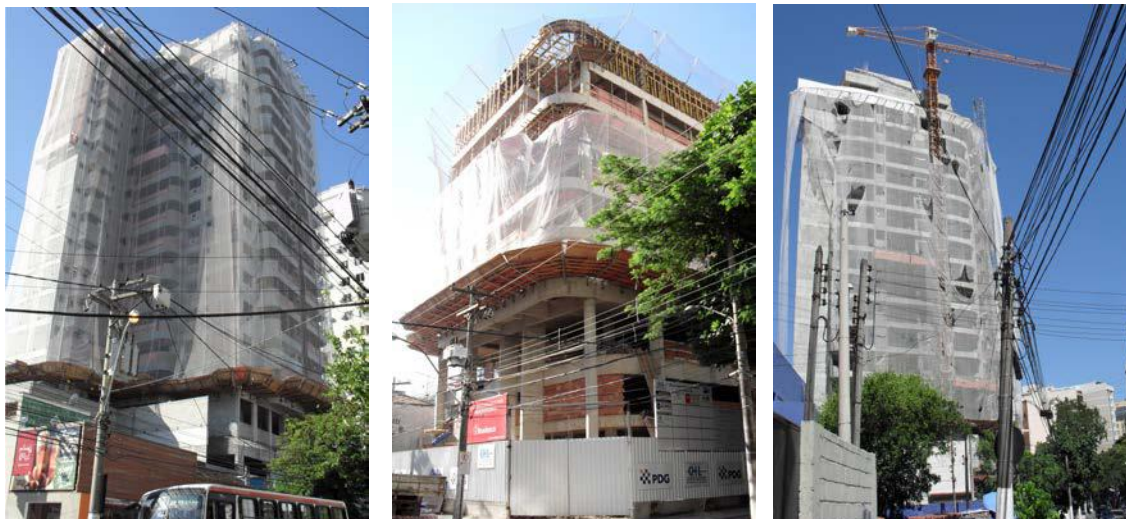
Figuras 6, 7 e 8: Na esquerda, o condomínio “Residencial Novo Jardim” na Rua Noronha Torreção 63, da Delta Construções S.A. No meio, o empreendimento “Orchestra Condominium” localizado na Rua Pres. João Pessoa, 95 da CHL/PDG. A última é o condomínio “Tour de Saint Martin” também na Rua Noronha Torreção 144, lançado pela ANFRA Construções.
