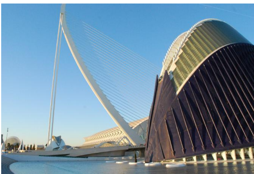
Cidade das Artes e das Ciências. Em primeiro plano, o Ágora, obra mais recente de Calatrava na região e onde acontece o torneio de tênis ATP Open 500 e o Fashion Week. O edifício é utilizado por duas semanas das 52 do ano, e sofre com goteiras nos dias de chuva. O projeto ainda não está totalmente concluído, faltando as viseiras da cobertura (CIUTAT, 2012).
