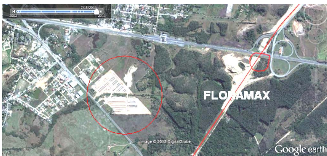
Figura 32. Área urbanizada (entre 2010 e 2011) próximo a Floresta Nacional Mario Xavier
