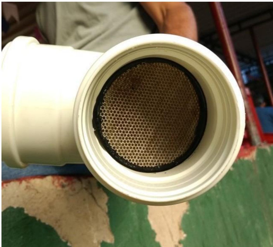
Figura 3: Filtro seletor de águas - usado no sistema de coleta de água da chuva na comunidade do Morro azul.
