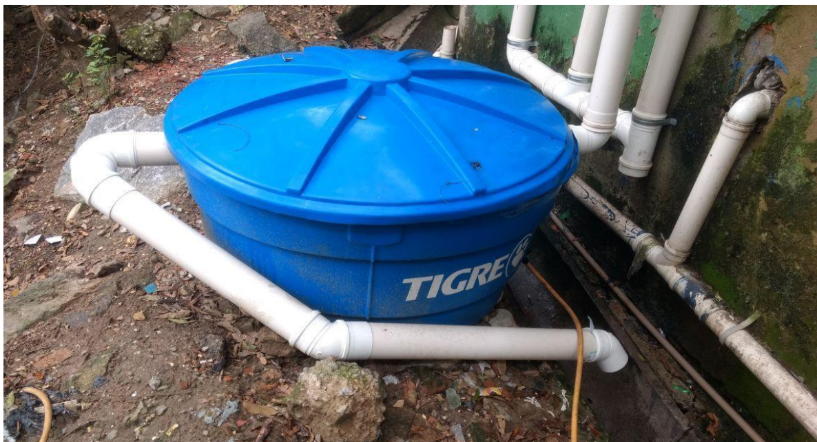
Figura 16: Desvio do transbordo para a canaleta.
