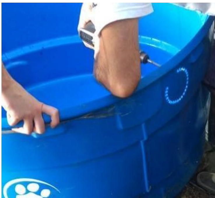
Figura 17: Efetuação de cortes na caixa d'água, para entrada de tubulação.
