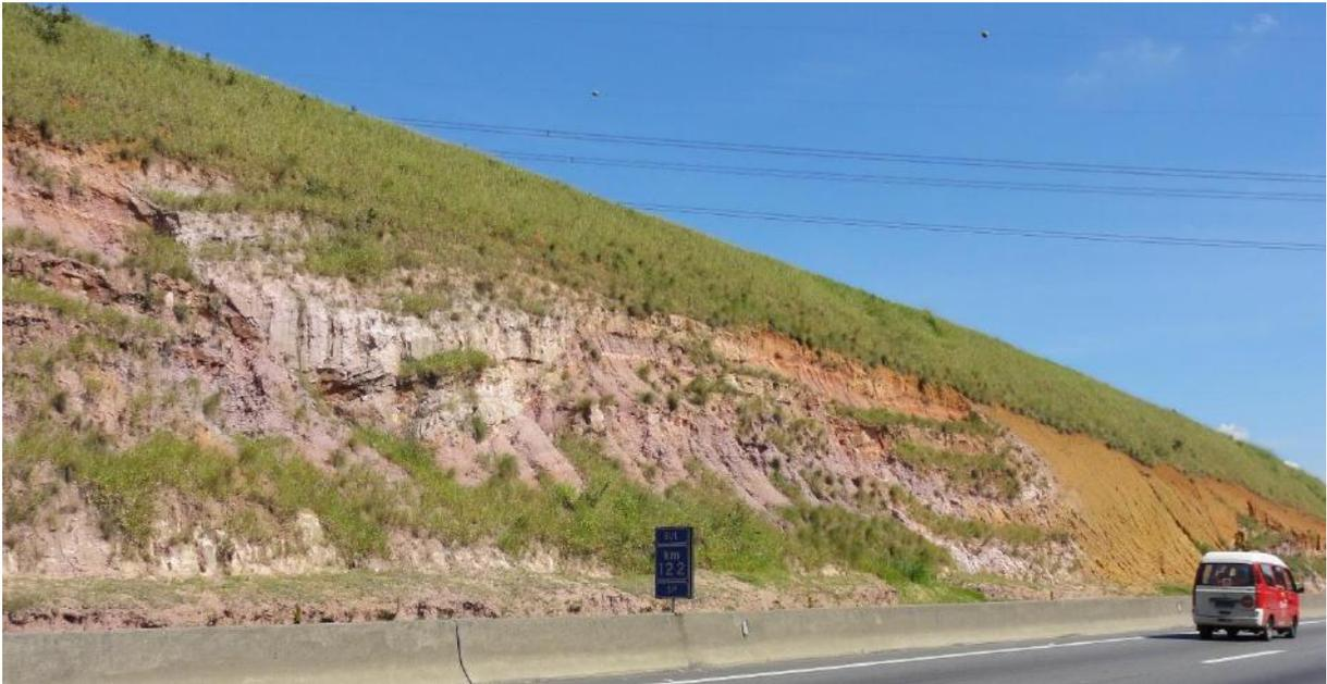
**Figura 9:** Vista geral do afloramento estudado. Corte de estrada com inclinação de aproximadamente  $50^\circ$  em relação a vertical.
