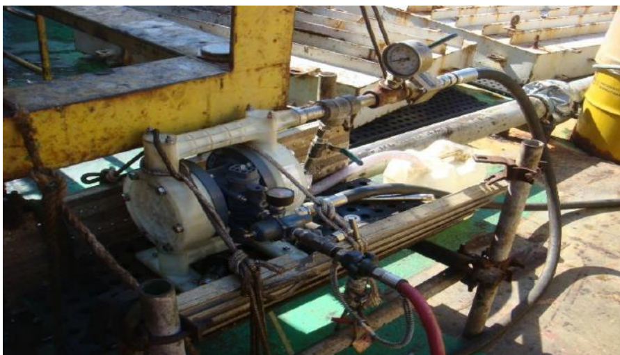
Figura 19 – Sistema provisório de injeção de sequestrante de H 2 S para offloading (Imagem cedida pela Petrobras UO-BC).
