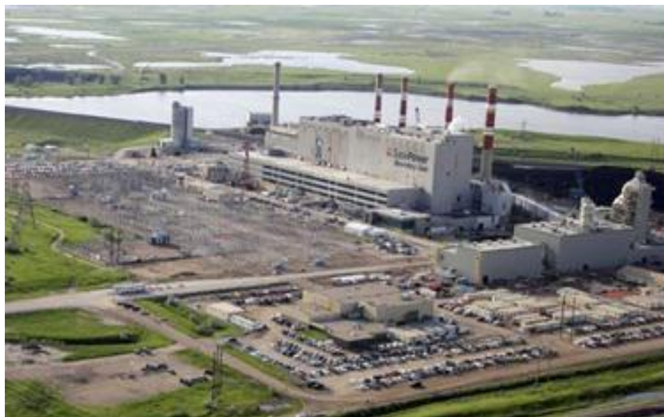
Figura 6. Planta de captura comercial de carbono instalada no Canadá. (fonte: ecycle.com.br).
