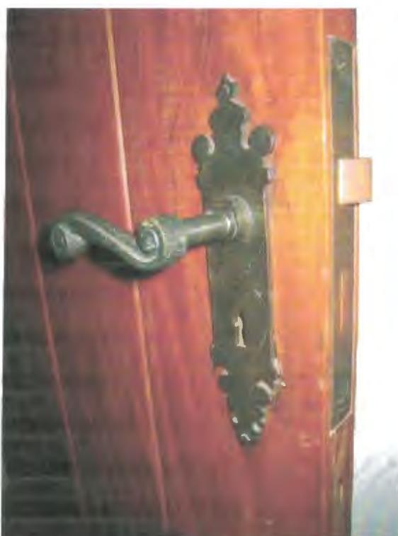
Figura 14 - Espelho e maçaneta de uma porta interna, executados em ferro batido.
