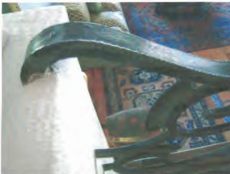
Figura 11 - guarda-corpo divisório entre as salas, feito em ferro batido.
