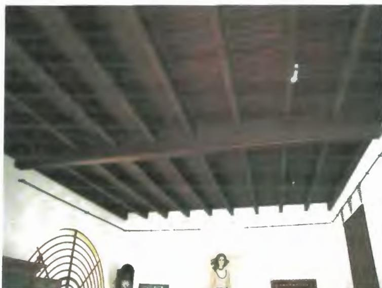
Figura 10 - assoalho (piso) do pavimento superior, sobre a sala/estúdio.
