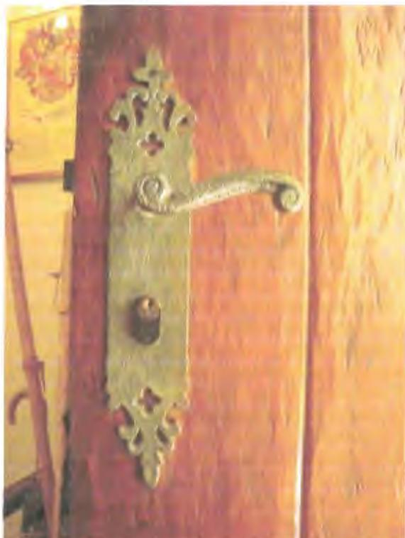
Figura 13 - Espelho e maçaneta da porta de acesso lateral, executados em ferro batido.
