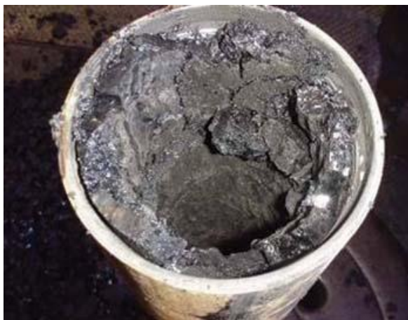
Figura 3: Depósito de asfaltenos numa linha de produção (Fonte: AGUIAR, 2013).
