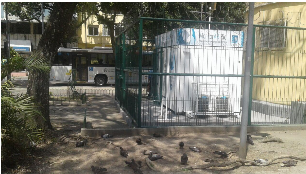
Figura 6: Estação de Monitoramento de Ar de Copacabana. Fonte: O autor.
