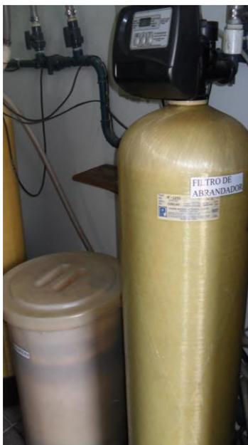
O filtro abrandador é utilizado com o objetivo de remover cátions tais como ferro, manganês e, principalmente, cálcio e magnésio, a fim de eliminar a dureza da água. Os íons são substituídos pelo sódio por meio do fluxo de água que passa por resinas catiônicas.<sup>5,21</sup>
