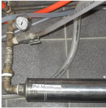
Figura 14: Pré-membrana do tratamento por osmose reversa
