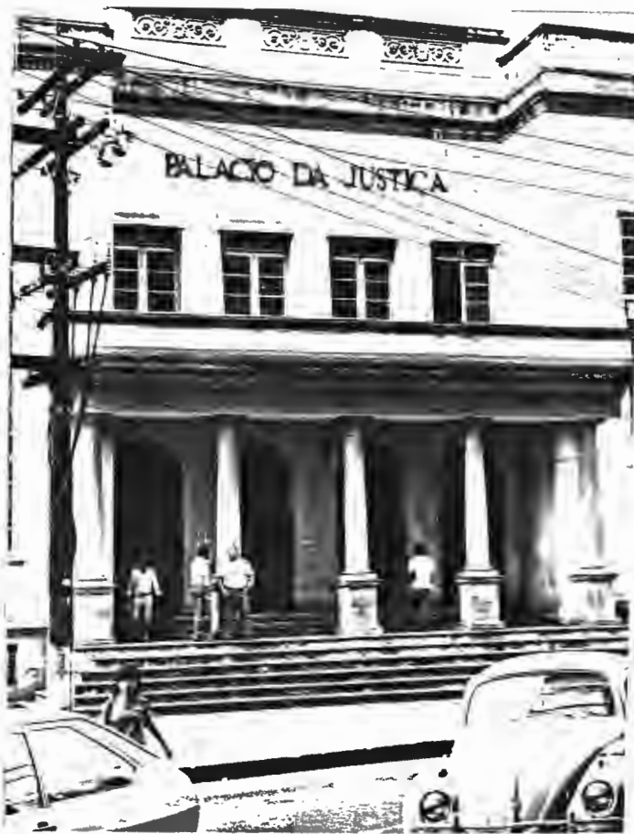
Figura 46 e 47: Fachada do Palácio da Justiça para a Rua Visconde de Sepetiba.
