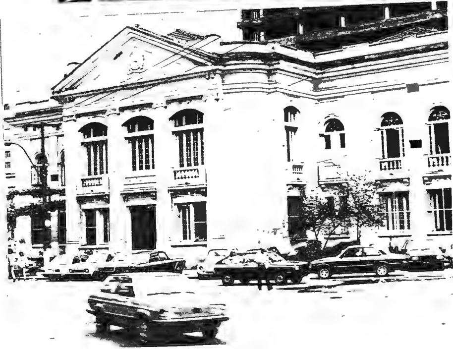
Figuras 58 e 59: Fachada do Arquivo Público para a Rua Dr. Celestino.
