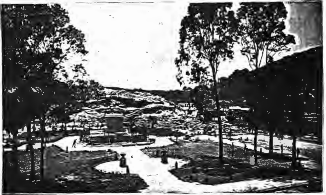
Figura 15a: Praça Pedro II em construção.
