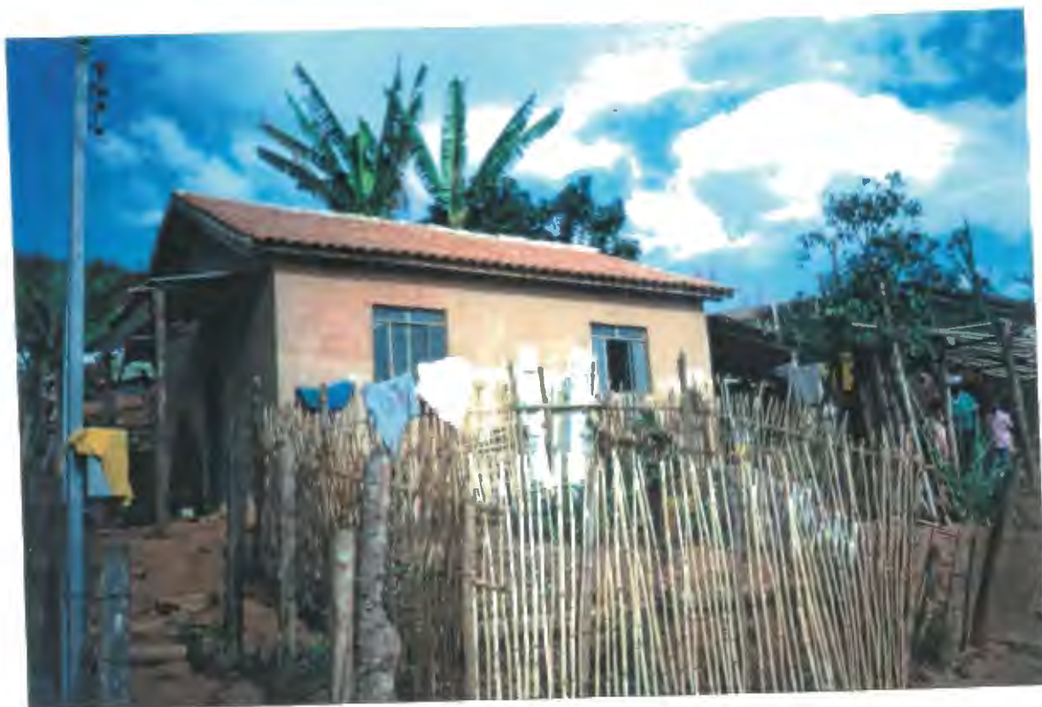
Fachada da casa
