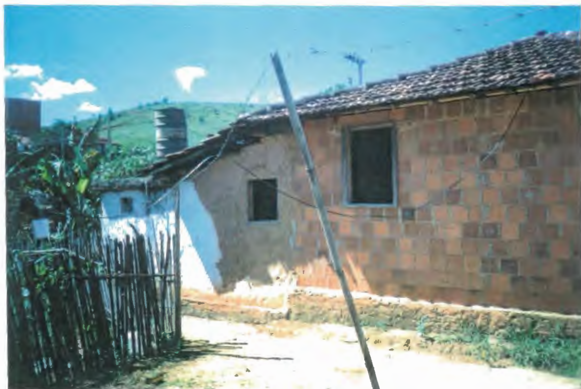
Marcas na fachada das diferentes etapas de construção da casa
