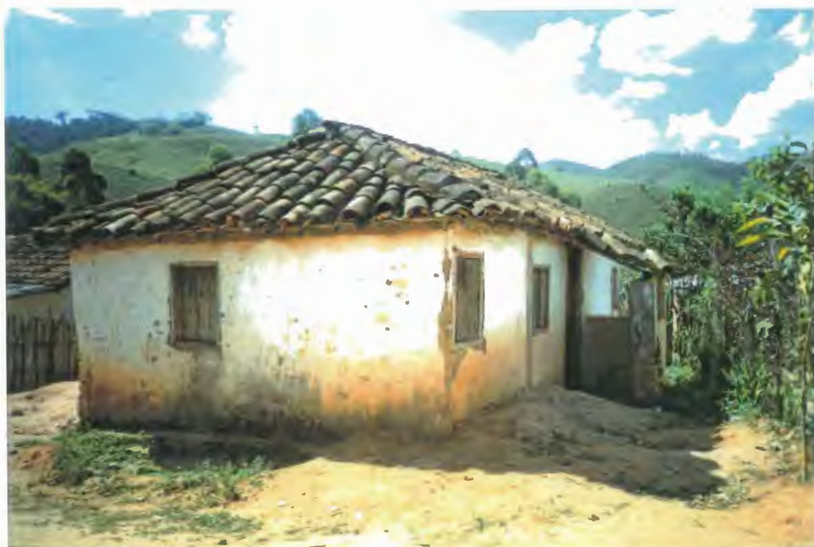
A mais antiga casa do bairro. Construída em adobe e pau-a-pique . Cobertura em telhas de bica .
