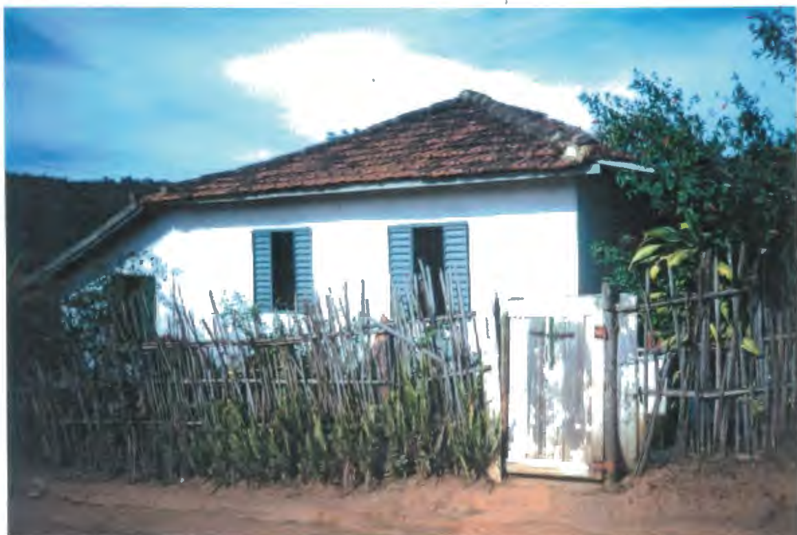
Fachada da casa
