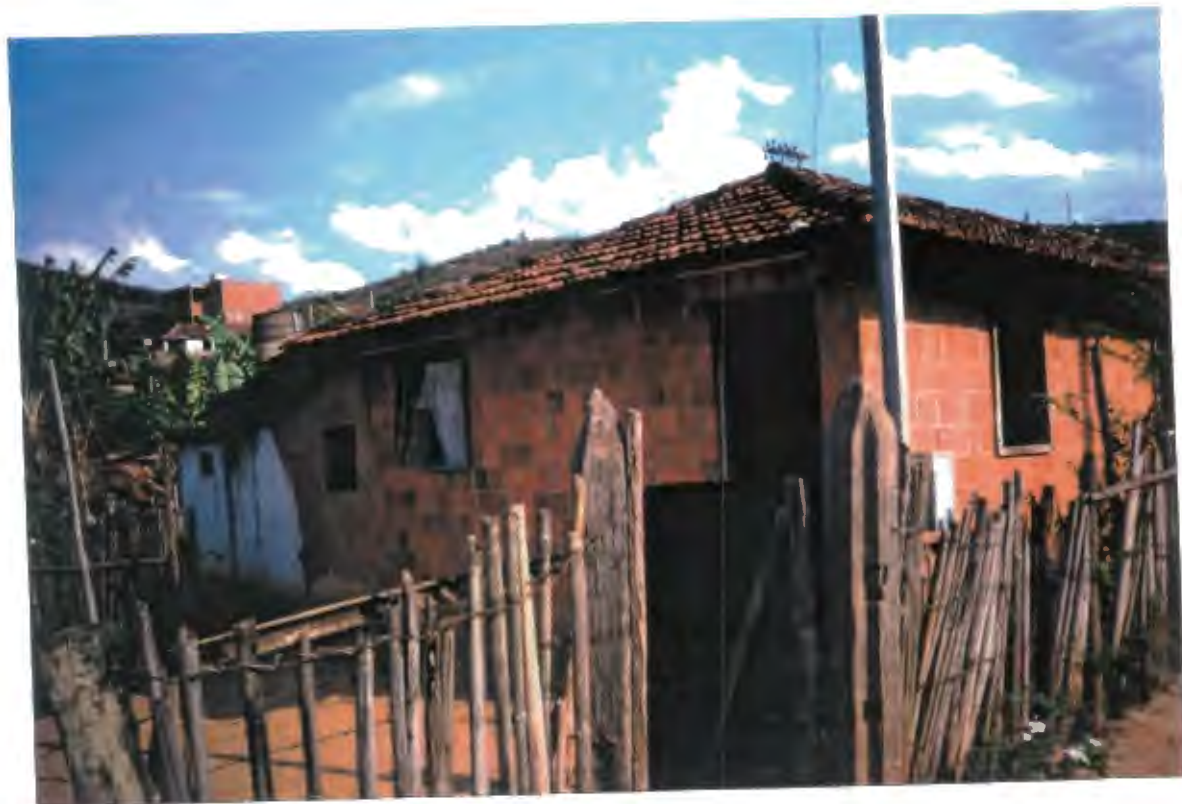
Fachada da casa
