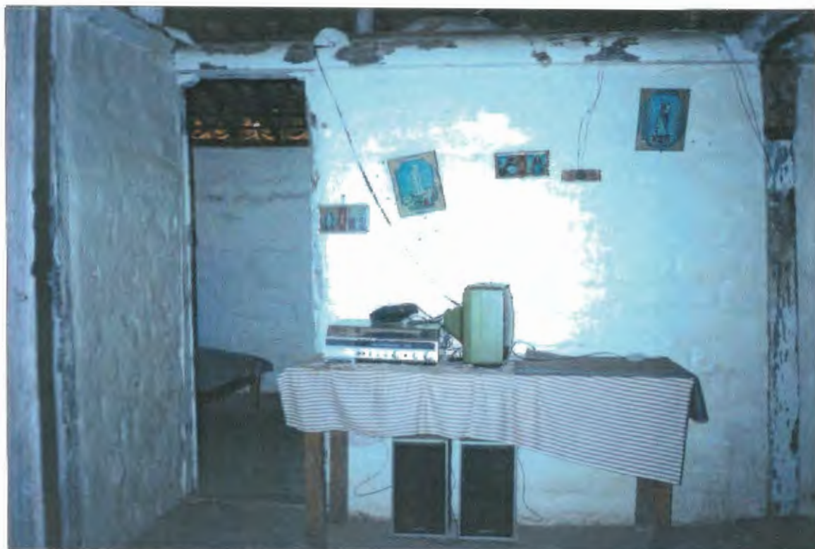
Sala – paredes revestidas com tabatinga
