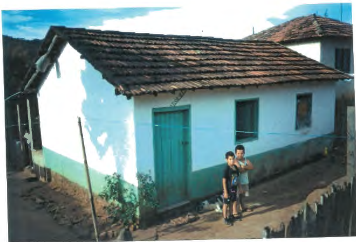
Fachada da casa
