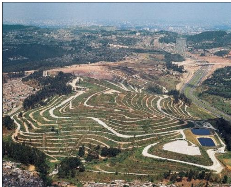
Figura 17 – Aterro sanitário de Bandeirantes em São Paulo (HELENO & FONSECA CONSTRUTÉCNICA S.A., 2009)
