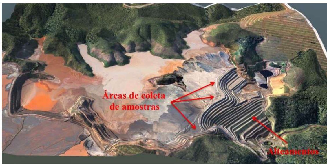
Figura 4.2 - Locais de retirada das amostras na barragem (FLÓREZ, 2015)
