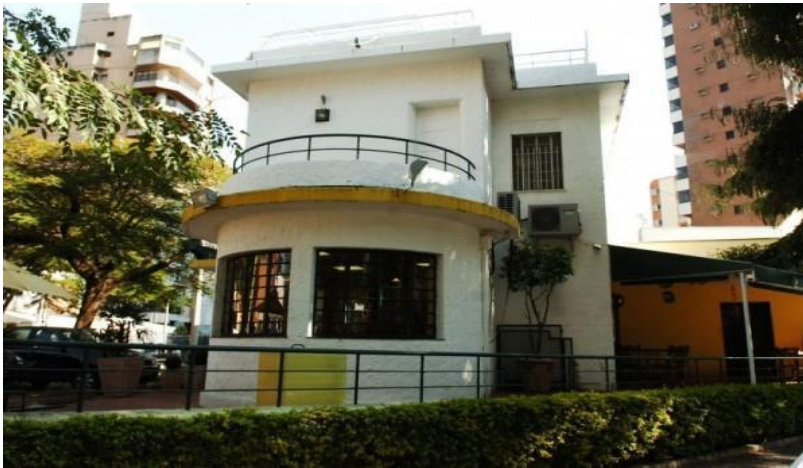
“A casa futurista”, projeto de Mário de Camargo Penteado, 1934, em Campinas, cidade natal do autor. Janelas em forma de escotilha, formas e desenho do terreno aludem a um barco. Localizada em rua cara ao autor, na esquina da floricultura de sua mãe.
