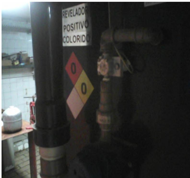
FIGURA 9 : Tanque com o Diamante de Hommel fixado
