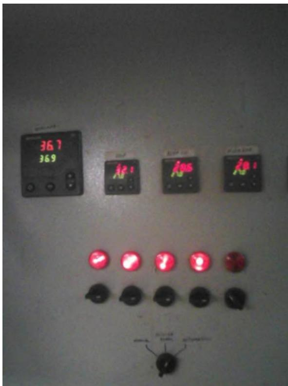
FIGURA 6 – Quadro com demonstração da temperatura de cada banho químico
