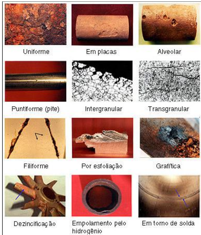
Figura 2: Formas de Corrosão [2].
