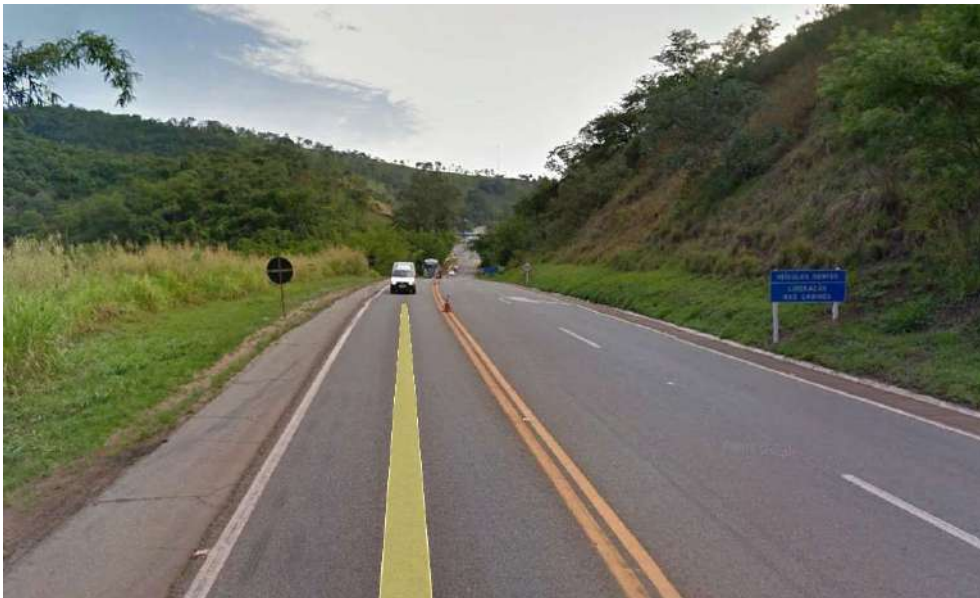
Figura 5.16: Sinalização vertical para veículos isentos
