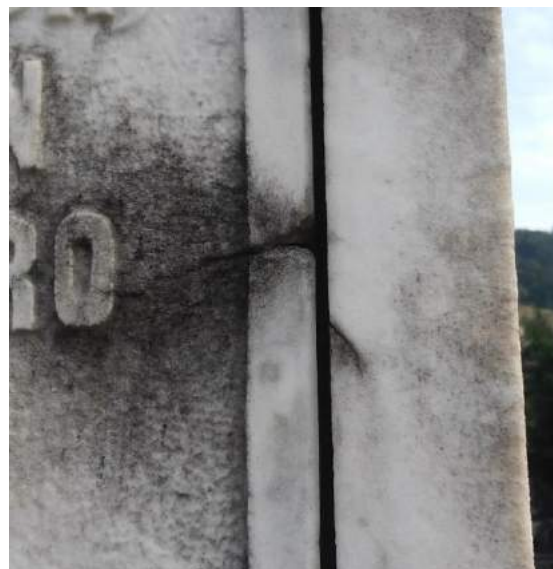
Fig.18 - Fenda na lateral esquerda do túmulo Fonte: Alves, 2017
