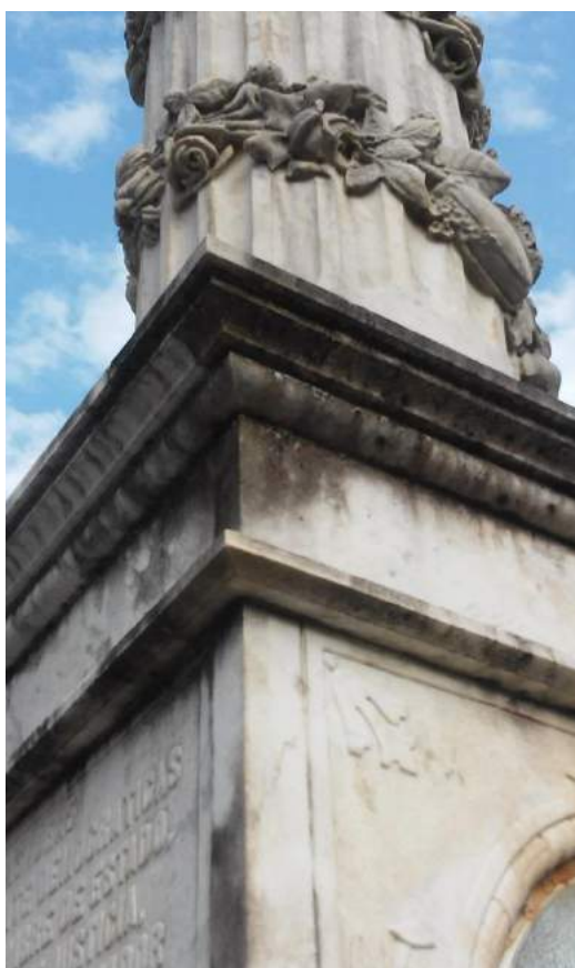
Fig. 21 – Crosta na base da coluna
