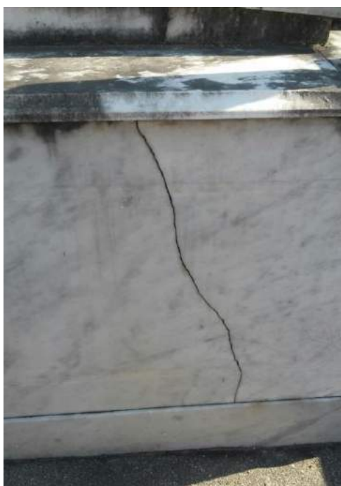
Fig. 19 – Fenda na lateral do túmulo Fonte: Alves, 2017
