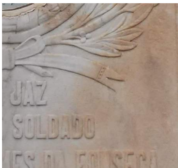
Fig. 23 – Alteração cromática alaranjada Fonte: Alves, 2017
