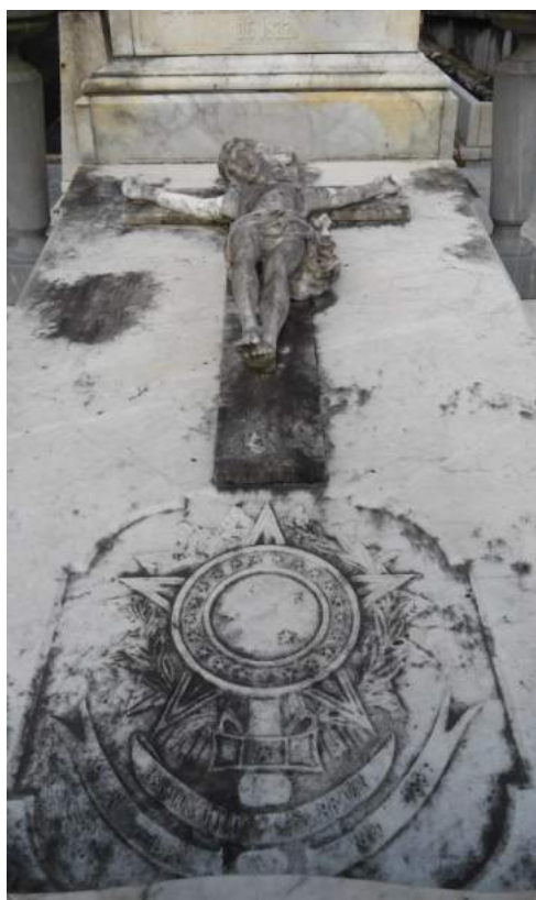
Fig. 22 – Depósito de fuligem Fonte: Alves, 2017
