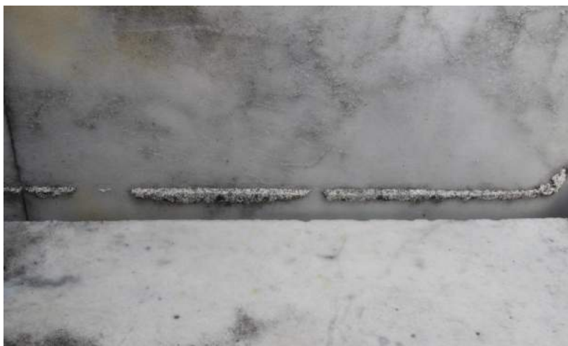
Fig. 26 – Restos de concreto agregados ao mármore
