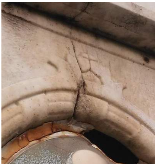
Fig. 17 – Fenda na parte frontal do túmulo Fonte: Alves, 2017
