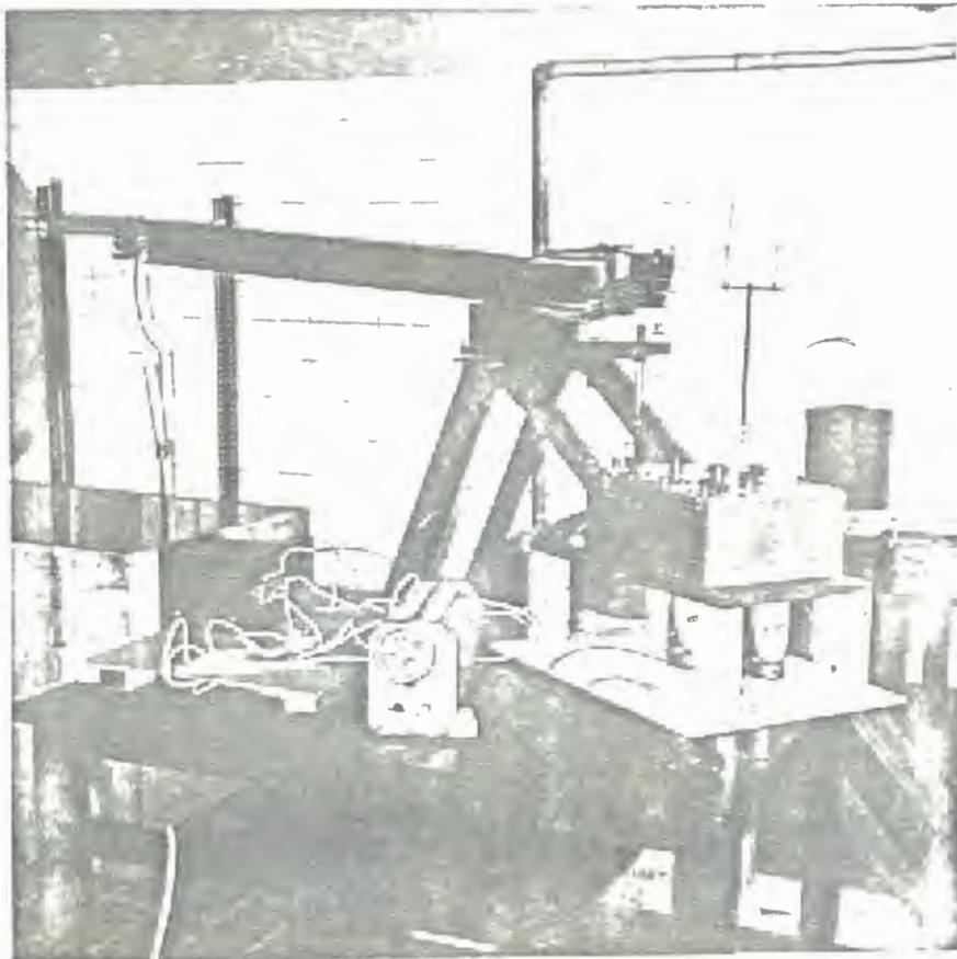
Fig. 5 - Fotografia mostrando em primeiro plano, à esquerda, o sistema de controle do forno da máquina de fluência e, à direita, o potenciômetro utilizado para a medida da temperatura do banho de sais fundidos. Em segundo plano, vê-se a máquina de fluência, com o relógio comparador aparecendo na extremidade esquerda. Ao fundo, a instalação de austenitização.
