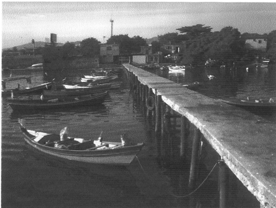
Foto 02 – Cais construído pela associação de pescadores no Bairro do Gradim/SG onde é realizada todos os dias a venda de pescado.
